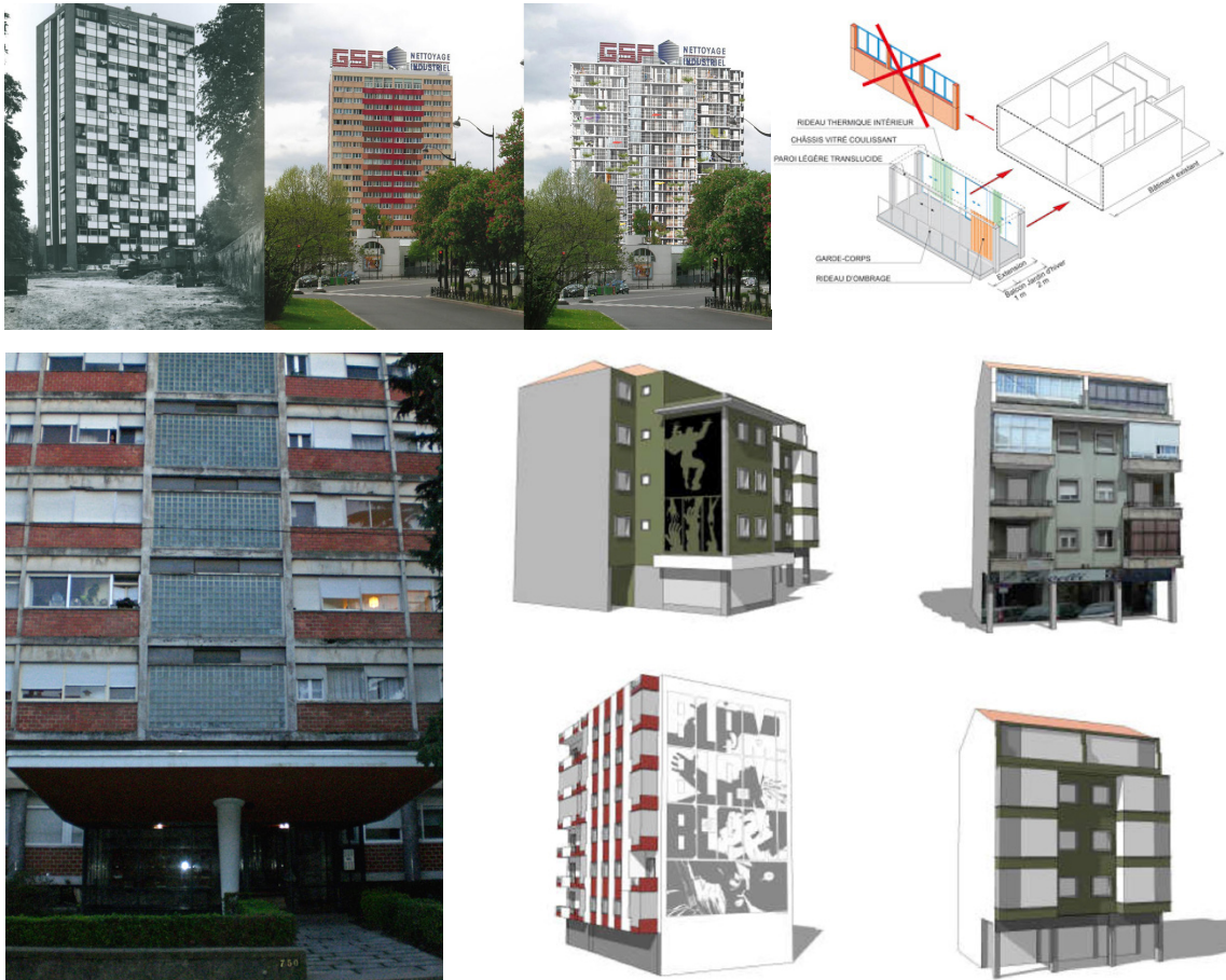
Torre de Bois le Prêtre, evolução; Torre de Bois le Prêtre, esquema da intervenção; Bloco Costa Cabral do Arq. Viana de Lima, 1953; Requalificação de Edifícios na Amadora
