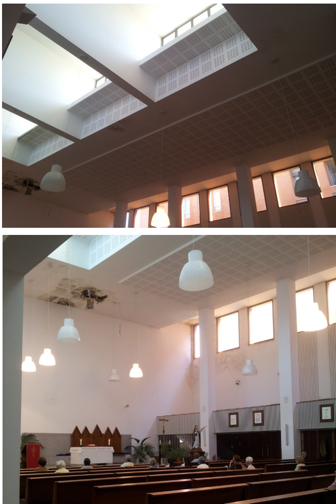
Fig. 117– Aberturas de Luz na cobertura; Fig. 118 – Abertura de Luz laterais
