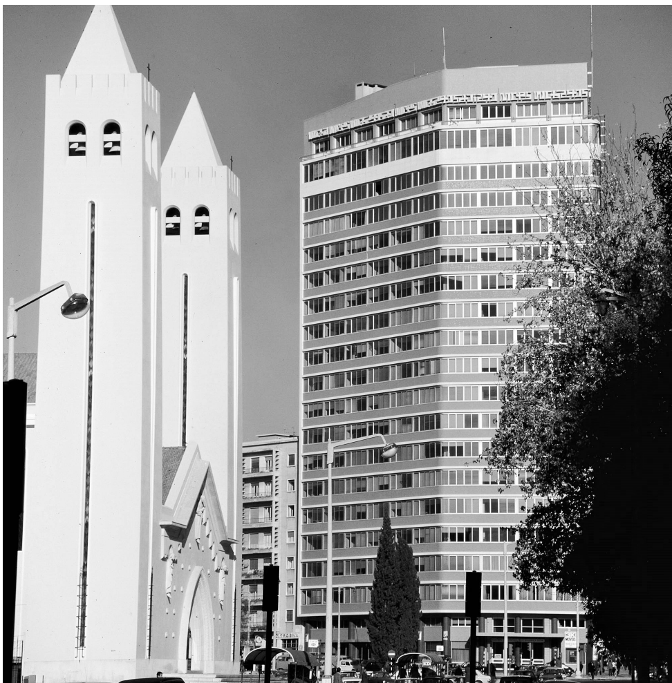
Fig. 66 – Monumentalidade da fachada
