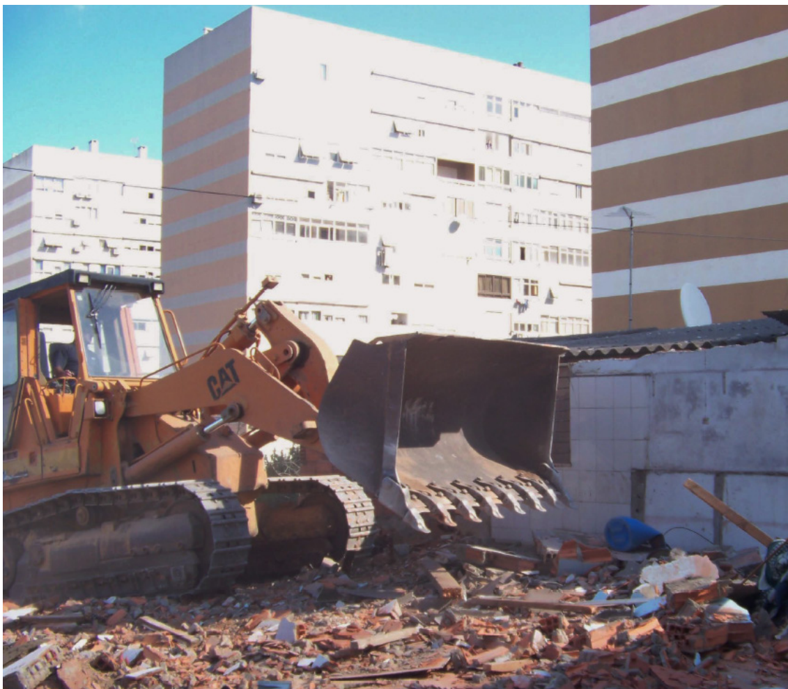
Quinta da Vitória - demolição do bairro de gênese ilegal
