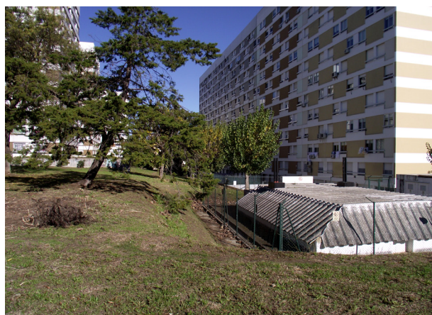
Depósito de gás , numa zona descaracterizada, junto à Estrada de Circunvalação
