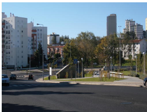
Zona Sul: Jardim novo não utilizado
