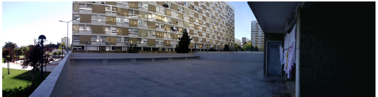
Vedação dos embasamentos e diferença de cotas entre os lotes da Portela e o Parque Urbano da Portela
