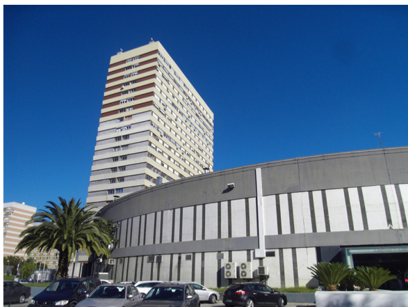
Torre de Escritórios e Centro Comercial
