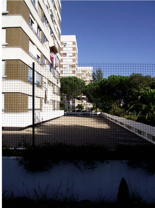
Vedações em torno dos embasamentos
