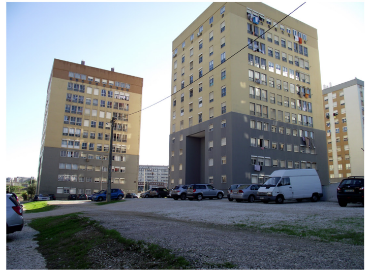
Área de Expansão, falta de percursos, maioritariamente usado como estacionamento
