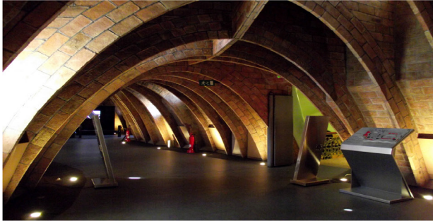
Fig. 1 - Parabolic arches, Attic Casa Milà, Barcelona, Spain.
