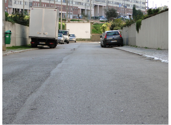
Rua entre lotes onde o passeio é utilizado para estacionamento
