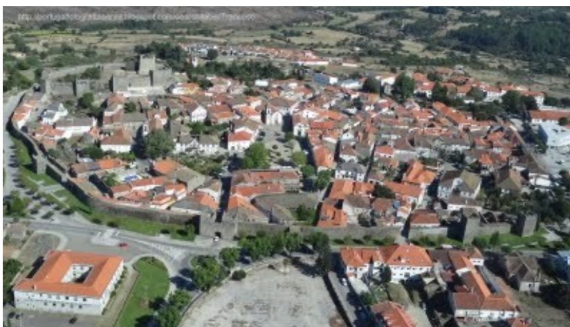
Figura 4.4 - Centro histórico de Trancoso - Perímetro muralhado
