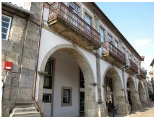
Figura 4.6 - Edifício reabilitado | Residência de estudantes da Escola Profissional de Trancoso
