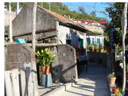
36 - Habitação - casal a (1ª geração) - Chiqueiros e cozinha - Vistas da habitação
