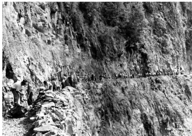
7 - Construção da Levada do Norte (Lanço Sul - décadas de 40/50 do séc. XX) in Madeira Quase Esquecida
