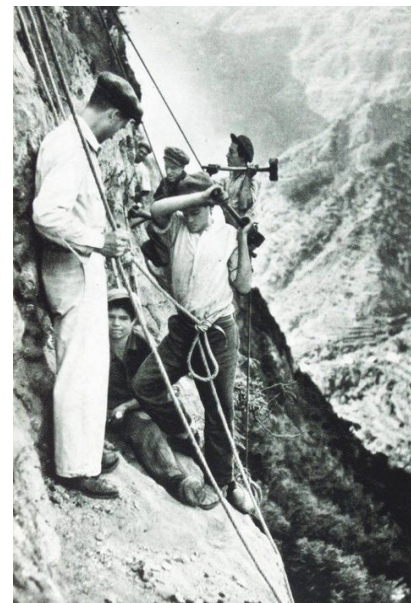
8 - Construção da Levada do Norte. Foto Perestrellos. (JLS) in Madeira Quase Esquecida
