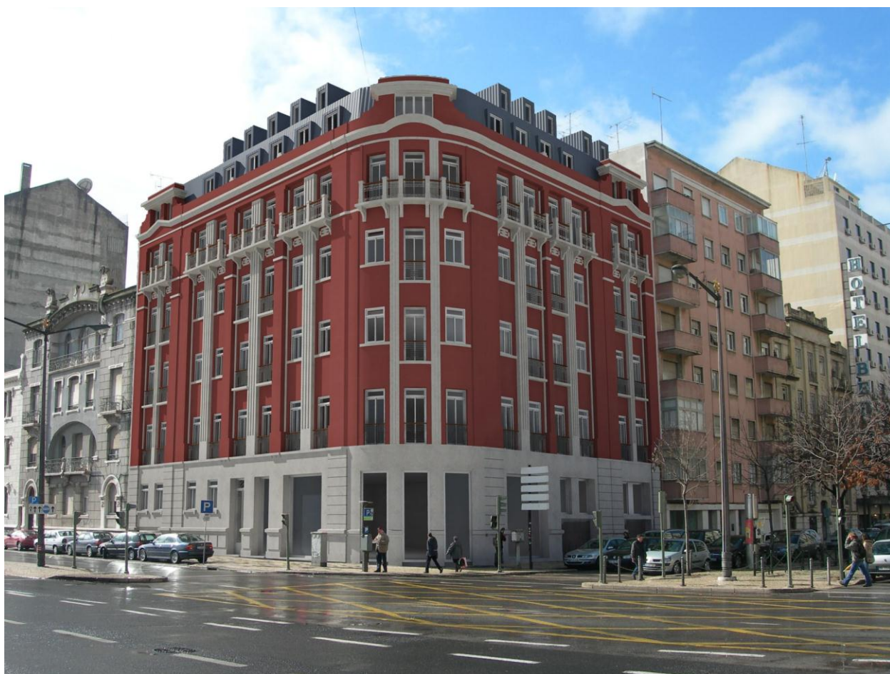
Figura 18 – Maquete do imóvel após as obras de reabilitação
