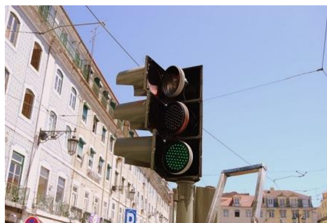
Figura 2.9- Semáforo com ópticas a led
