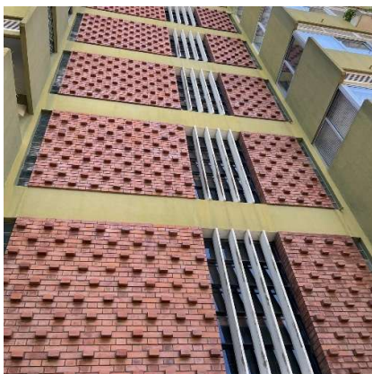
Figura 35 – Exemplo de detalhe de Tijolo maciço na fachada do edifício em Olivais Sul. Fotografia da autora, 17/07/2025
