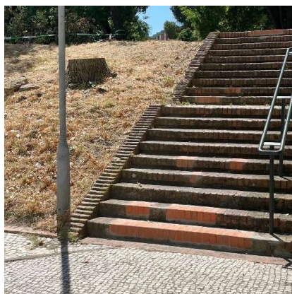
Figura 38 – Exemplo de escadaria em Tijolo maciço em Olivais Sul. Fotografia da autora, 17/07/2025
