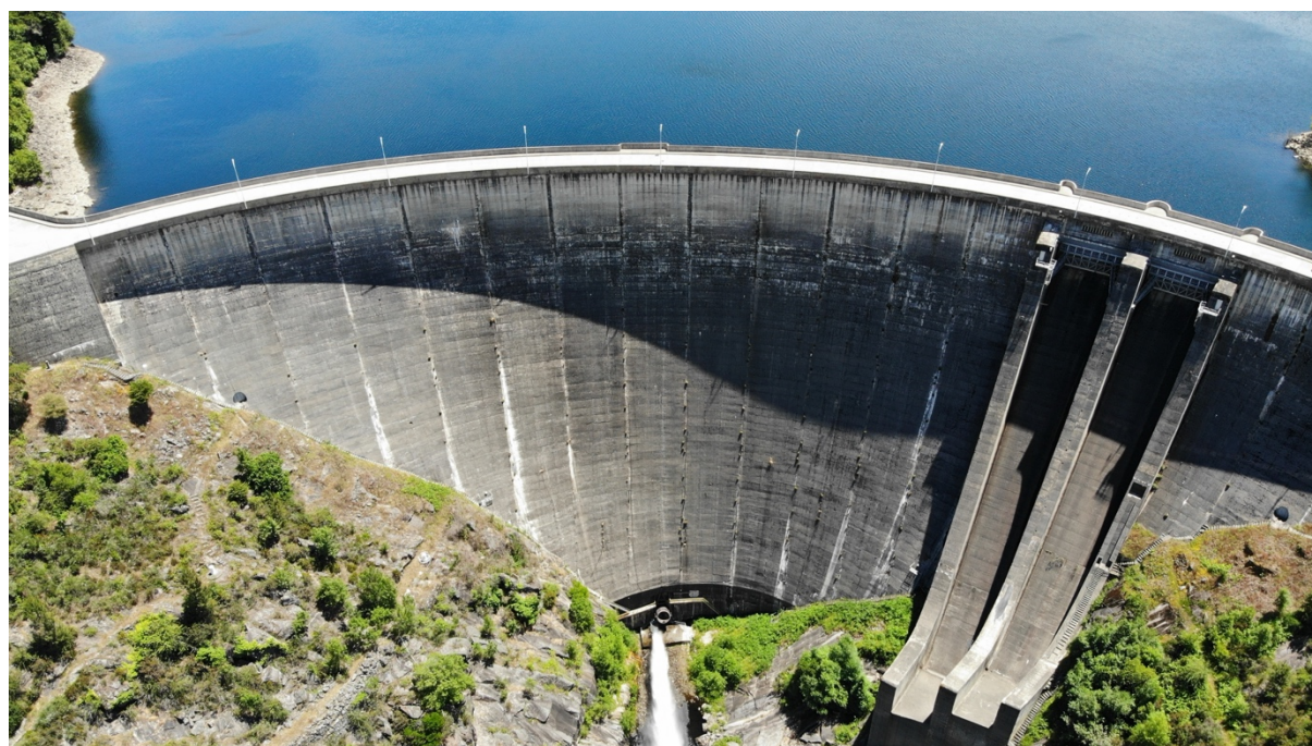
Fig 57 . Barragem da Venda Nova . fotografia do autor
