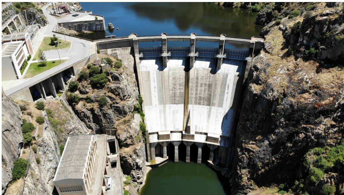
Fig 76 . Barragem de Carrapatelo e Picote . fotografia do autor
