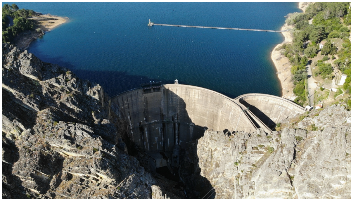
Fig 70 . Barragem de Santa Luzia . fotografia do autor
