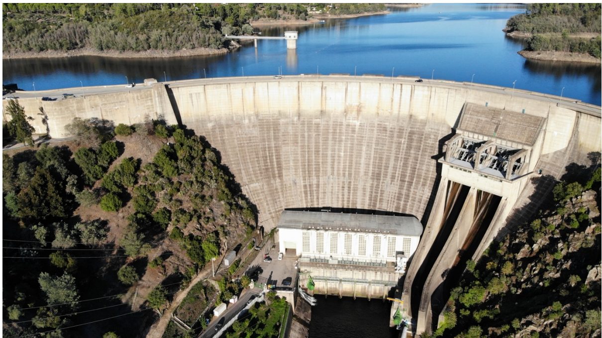
Fig 64 . Barragem de Castelo de Bode . fotografia do autor
