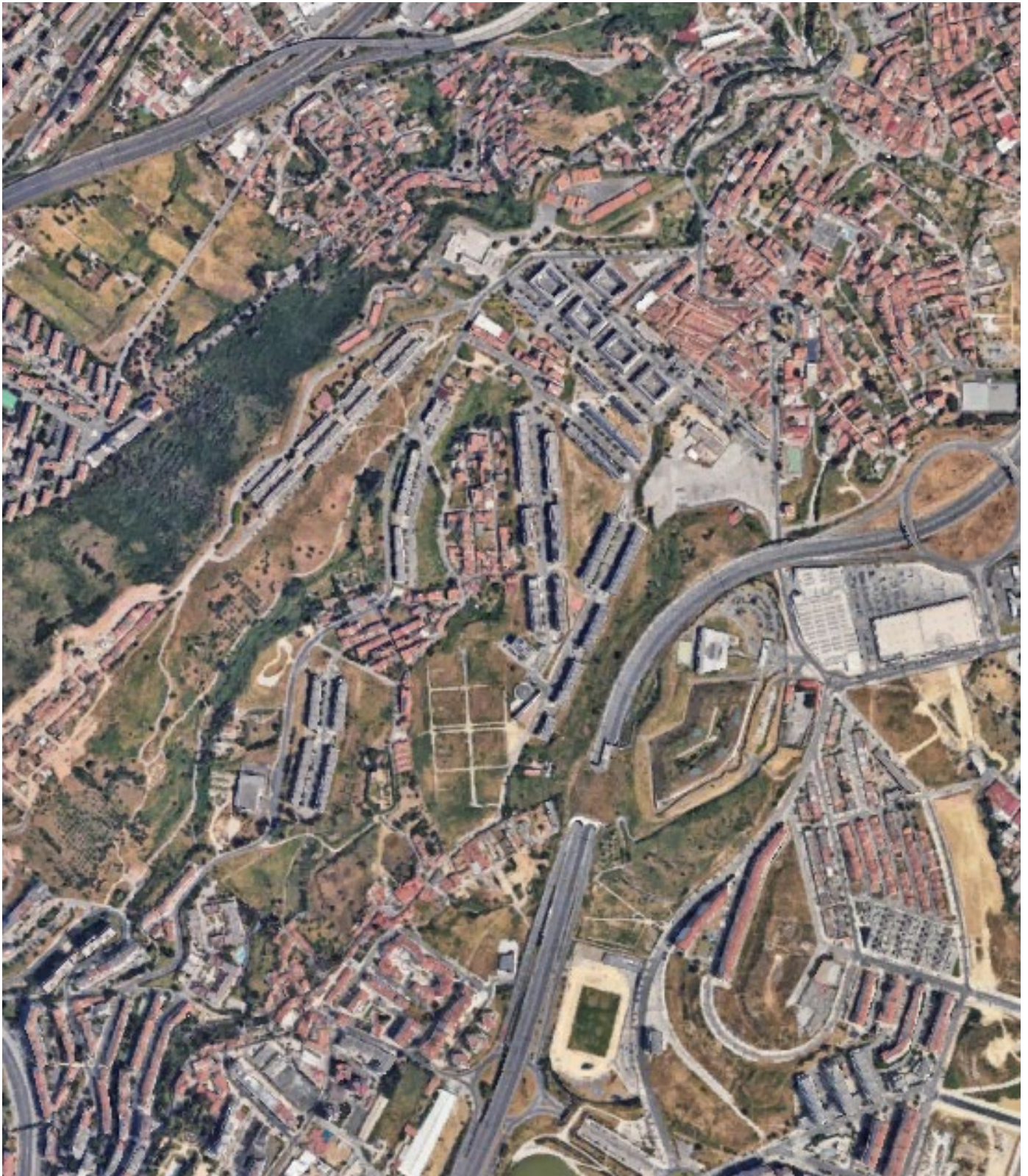
Figura 21- Vista aérea da área das Galinheiras/ Ameixoeira (Fonte: Google maps)
