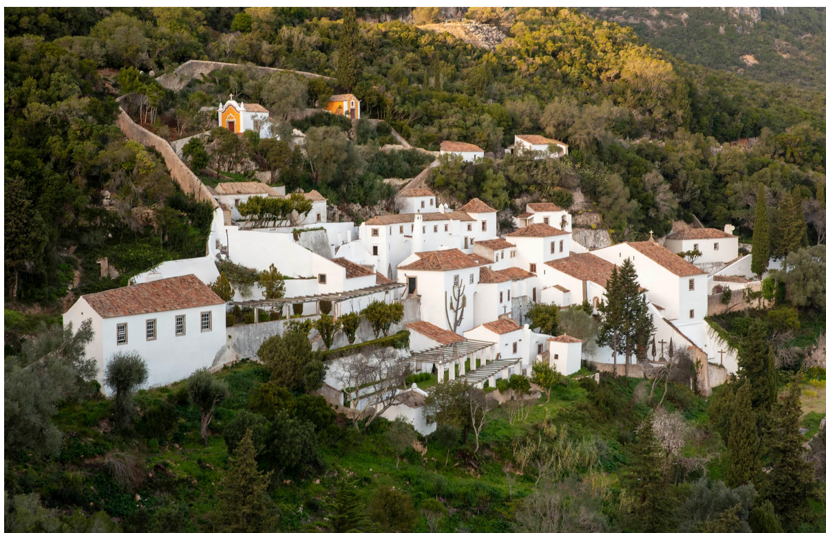
Fig.11 Perfil do Convento de Nossa Senhora da Arrábida, Carvalho Quintela et al.(1996) Fig. 12 Espaço exterior do convento Charlotte Schönberger, data desconhecida Fig.13 Ponto de vista do Convento Jacek Sopotnicki, 2021
