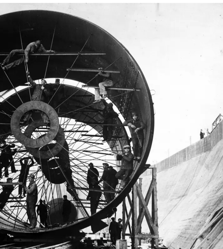
Figura 10. (Autor desconhecido) Fotografia da montagem de uma das turbinas da central hidroelétrica, Fonte: Fundação EDP
