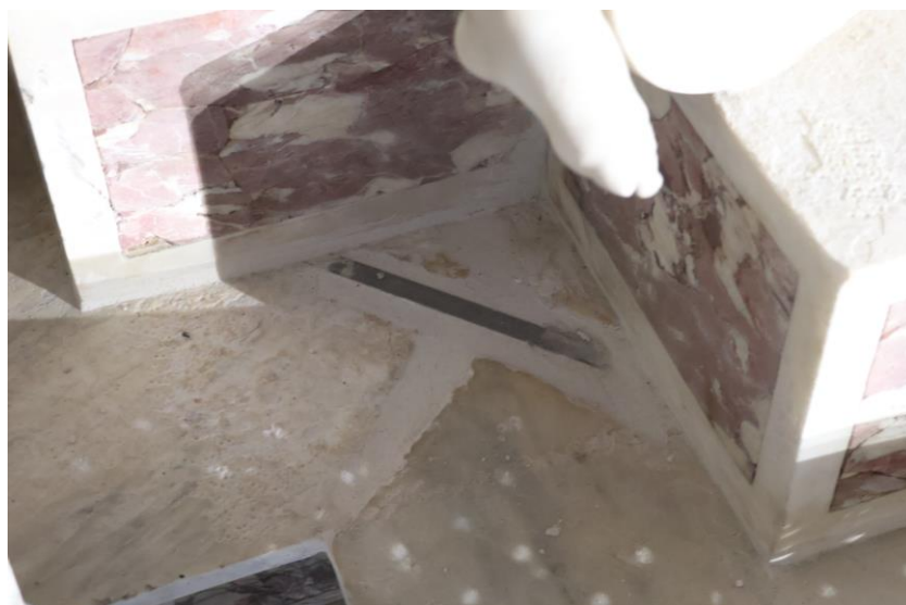
Figura 26 – Vista de nuevo anclaje sustituido. Fotografía del autor durante la restauración.
