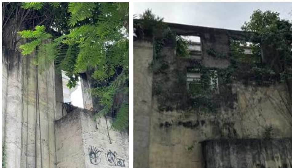
Figuras 11 e 12. Detalhes dos recortes no muro remanescente e dos volumes em concreto aparente em balanço utilizados como canteiros ou como fontes de água. Fotos Michael Morouço, 2024. Acervo LabLugares PROARQ/FAU/UFRJ.
