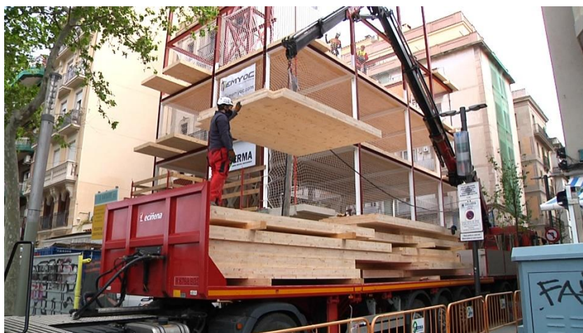
Fig. 8 – La Xarxaire, montaje en seco de los elementos principales de sus estructuras vertical y horizontal, de pilares y vigas de acero y paneles de madera estructural (La Mar d’arquitectes). Fuente: página web de Betevé ( https://beteve.cat/societat/construccio-edifici-xarxaire-sostenible-barceloneta/ )
