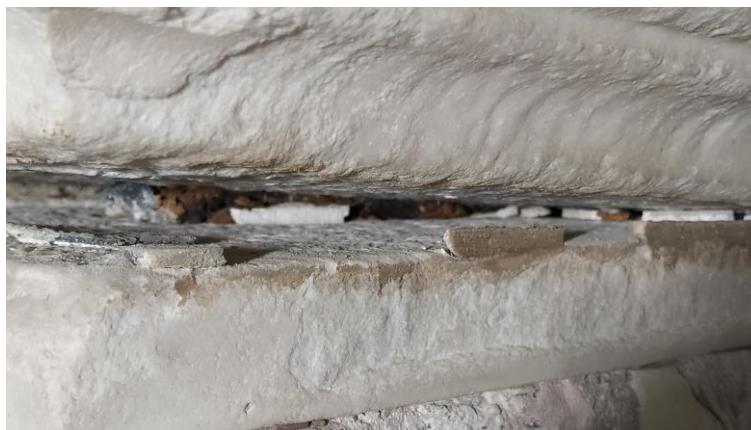
Figura 39– Vista de junta de apoyo entre piezas de mármol sin mortero de cal. Fotografía del autor.
