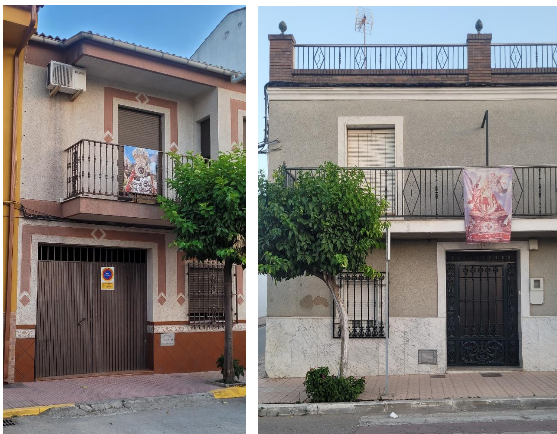
Figura 12 –Fotografías actuales de balcones en Mengíbar tomadas por las autoras.
