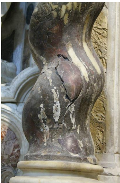
Figura 20 – Vista de diversas patologías en el mármol del fuste de una de las columnas. Fotografía del autor antes de la restauración.
