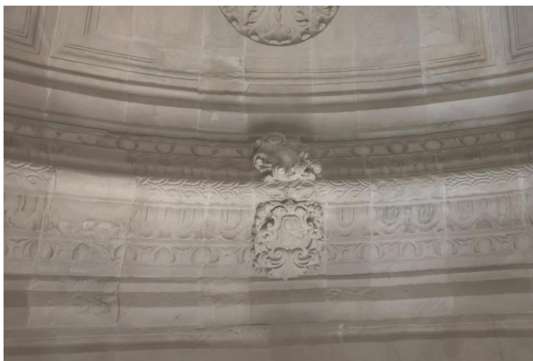
Figura 38– Vista de reconstrucción volumétrica de nervadura en la bóveda finalizada. Fotografía del autor.
