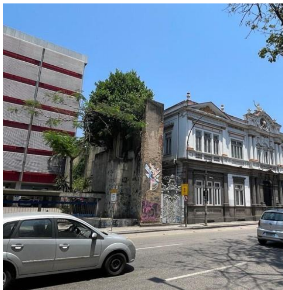
Figura 5: Muro que separa o terreno do HMSA (à esquerda) do Palácio da Saúde do Ministério de Guerra (à direita). Vista da rua. 2024. Foto Michael Morouço, 2024. Acervo LabLugares / PROARQ / FAU / UFRJ.
