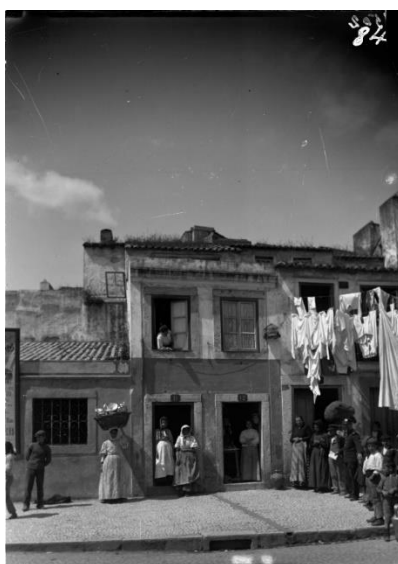
Fig. 1 - Largo de Santa Bárbara (Machado e Sousa, 1901-04-10, Arquivo Municipal de Lisboa - Fotográfico, cota PT/AMLSB/CMLSBAH/PCSP/003/FAN/001502)
