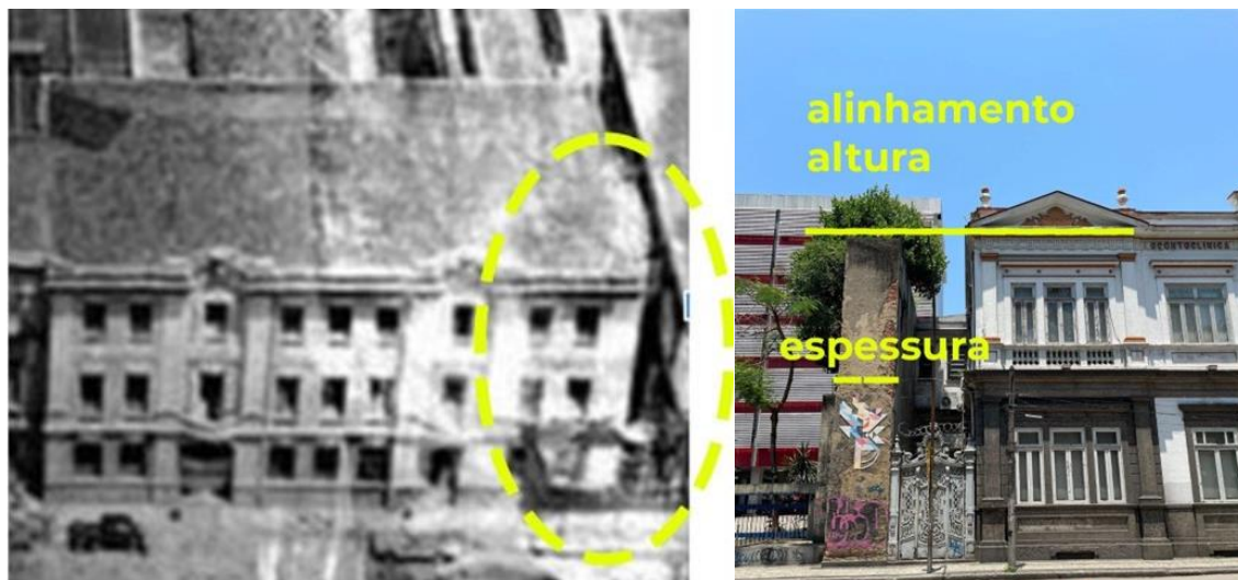
Figuras 16 e 17 – Comparação entre imagens, destacando o muro, na tentativa de se comprovar preexistências. Fontes: Adaptado por Michael Morouço (2024) sobre foto acervo AGMRJ (Figura 16); foto Michael Morouço, 2024 (Figura 17). Acervo LabLugares PROARQ/FAU/UFRJ.
