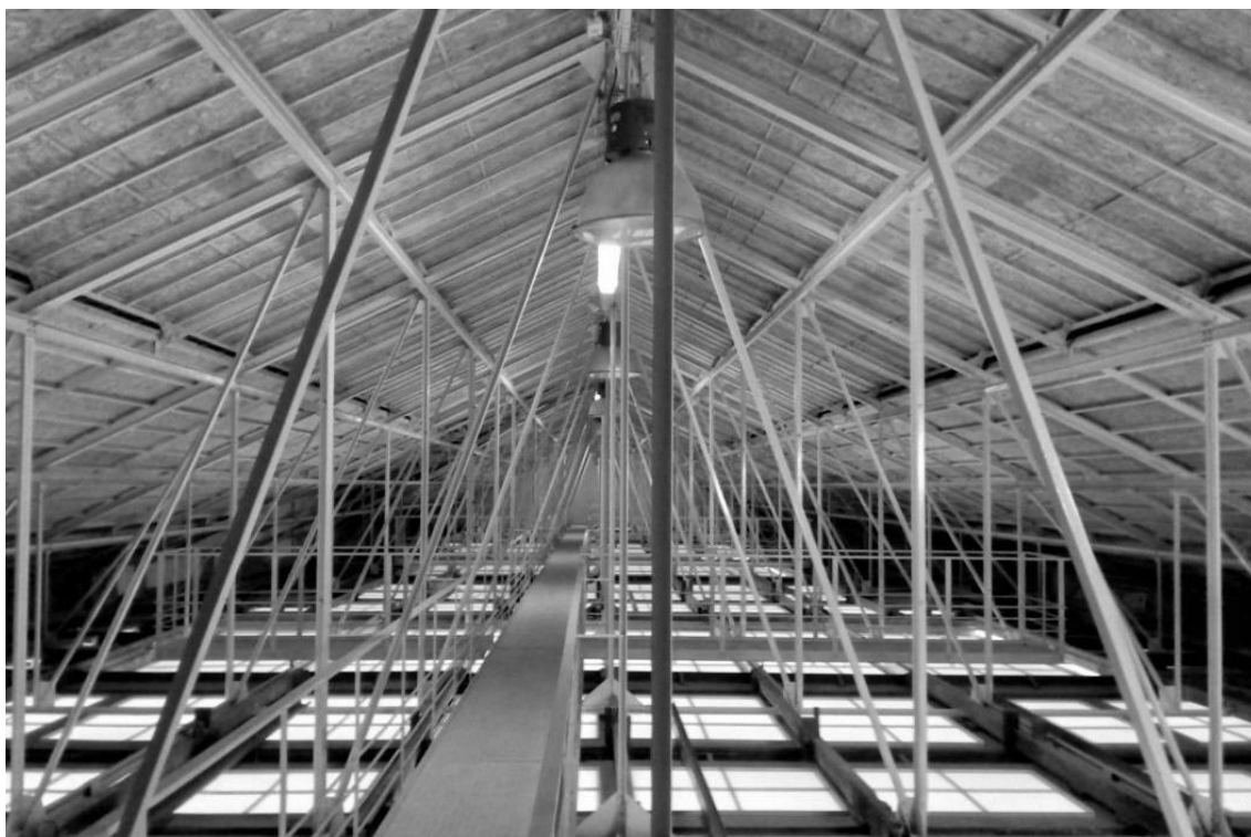
FIGURA 3 - Sede da Sociedade Nacional de Belas Artes – Lisboa – 1913 – Projeto de Álvaro Machado (1874-1944) - Vista da asna em perfis de ferro – fotografia de Nuno Magalhães
