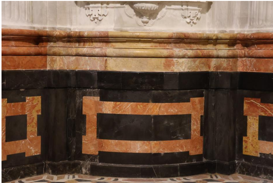
Figura 32 – Vista del zócalo tras finalizar la actuación. Fotografía del autor.
