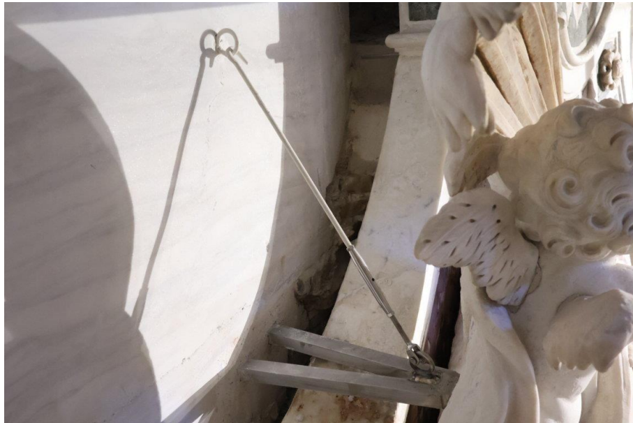
Figura 28 – Vista del nuevo anclaje trasero del ángel suspendido izquierdo en el ático del retablo. Fotografía del autor durante la restauración.
