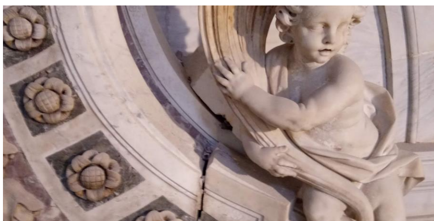
Figura 15 – Vista del desplazamiento de algunas piezas del ático del retablo. Fotografía del autor antes de la restauración.
