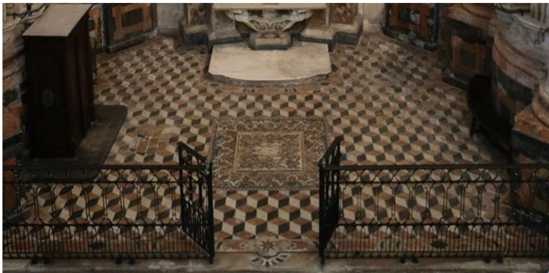
Figura 8 – Vista del pavimento de mármol de la capilla. Fotografía del autor antes de la restauración.
