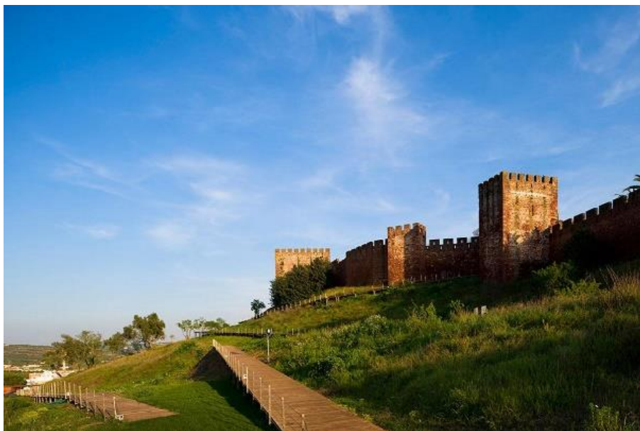
Figura 8 - Encosta do Castelo de Silves (Fonte: Divisare – Fernando Guerra).
