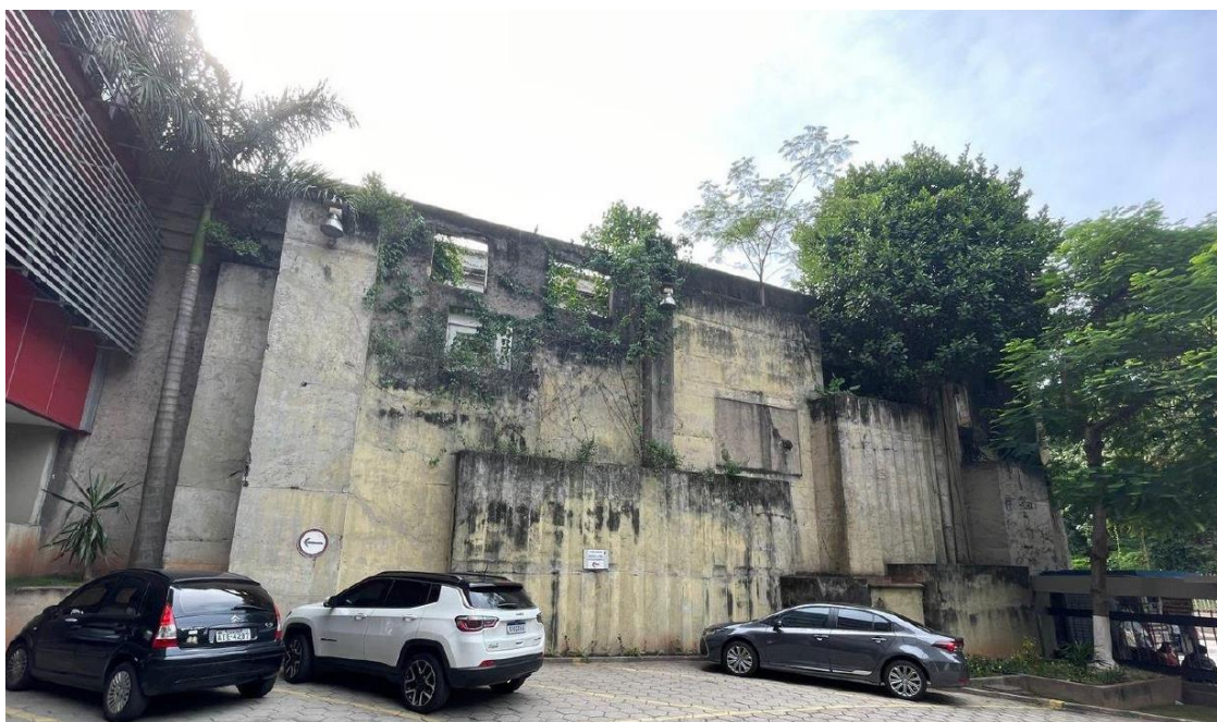
Figura 10 – Jardim vertical implantado em muro preexistente da edificação demolida. Foto Michael Morouço, 2024. Acervo LabLugares PROARQ/FAU/UFRJ.
