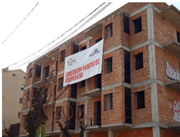
Fig. 5 – Imagen de la construcción sin finalizar, a raíz de la crisis inmobiliaria del año 2008, posteriormente acabada y rehabilitada para dar cabida a la cooperativa de viviendas de La Xicoira. Fuente: noticia en la página web del grupo promotor de Sostre Cívic ( https://sostrecivic.coop/es/tot-a-punt-per-comencar-les-obres-del-projecte-a-olesa/ )
