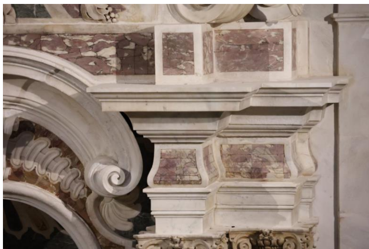
Figura 40– Vista de junta de apoyo tras la actuación de recolocación de piezas. Fotografía del autor.
