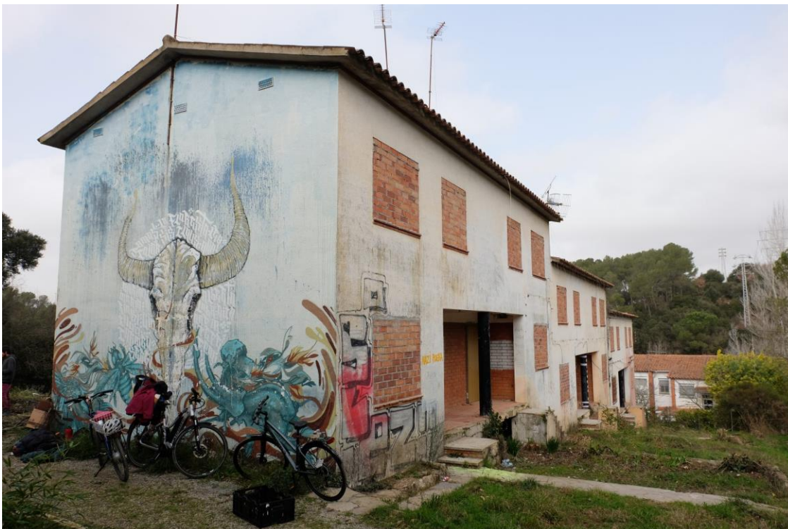
Fig. 9 – Clau Mestra, Antiguas Casas de los Maestros de la Floresta antes de rehabilitar (Sant Cugat del Vallès).
