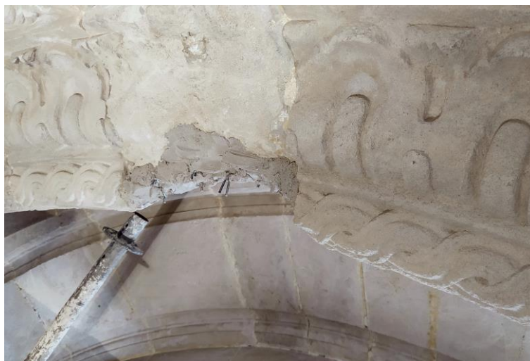
Figura 37– Vista de reconstrucción volumétrica en proceso de armado. Fotografía del autor.
