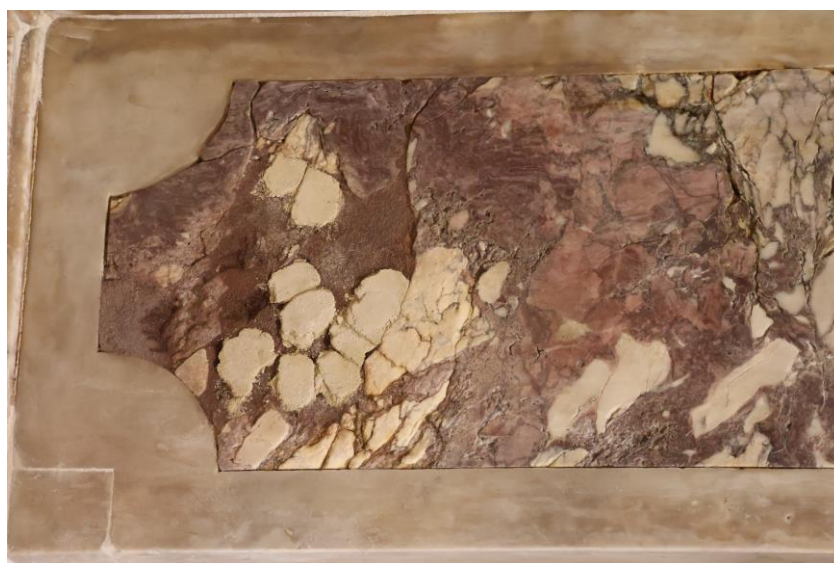
Figura 36– Vista de reconstrucción volumétrica de pérdida de incrustaciones de piedra. Fotografía del autor.
