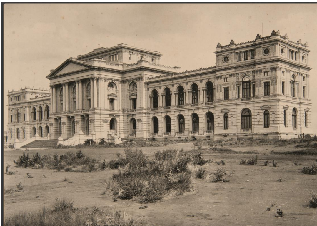
Figura 2 - Fotografia do Edifício-Monumento do Ipiranga, Fachada e Lateral Direita, 1892. Acervo do Museu Paulista da USP
