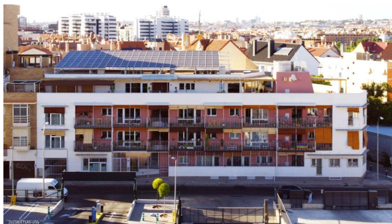
Fig. 10 – Vista general del proyecto de Entrepatis Las Carolinas (sAtt arquitectura). Fuente: imagen cedida por sAtt arquitectura.
