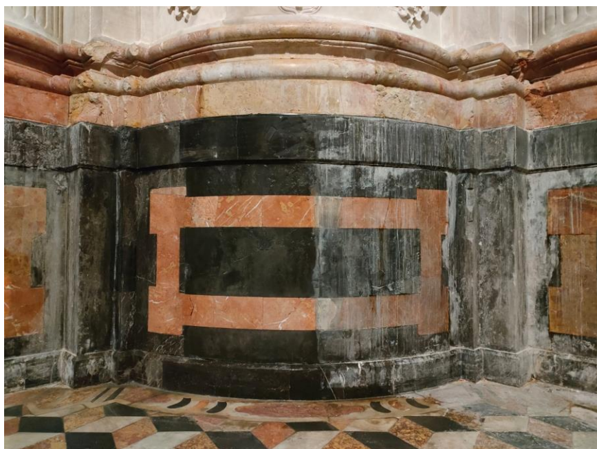
Figura 31 – Vista del zócalo durante el proceso de limpieza. Puede comprobarse el tramo que ya ha recuperado la intensidad cromática original. Fotografía del autor durante la restauración.
