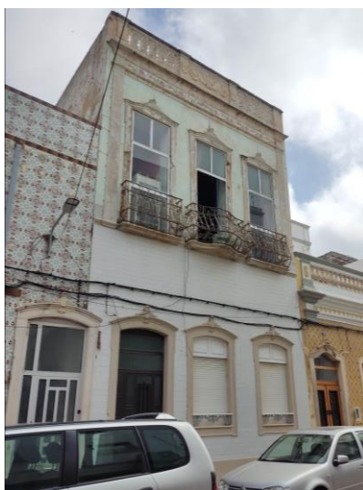
Figura 16 - O imóvel anterior com nova campanha de obras de construção de um piso. Fotografia de Sandra Romba
