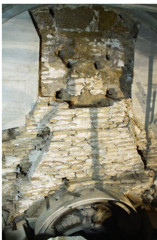
Figura 27 – Vista de la fábrica trasera tras la finalización del desmontaje de las piezas de mármol dislocadas. Fotografía del autor durante la restauración.
