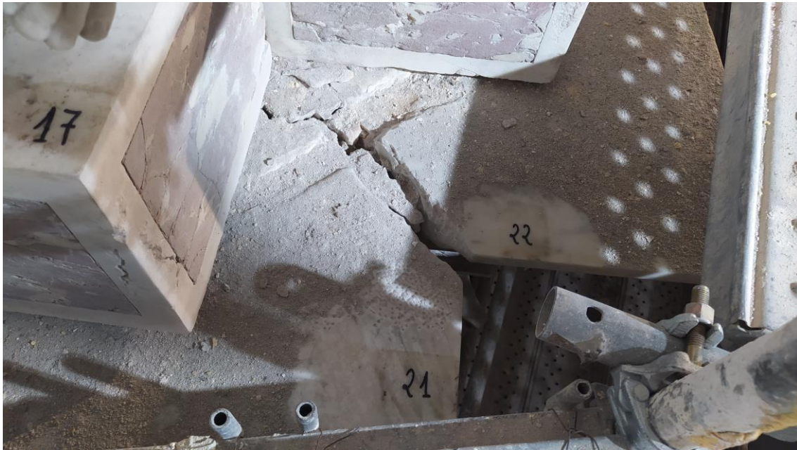
Figura 24 – Vista de la zona superior del apoyo sobre los capiteles durante el proceso de desmontaje. Se observa la numeración de las piezas independientes de mármol que forman el conjunto. Fotografía del autor durante la restauración.
