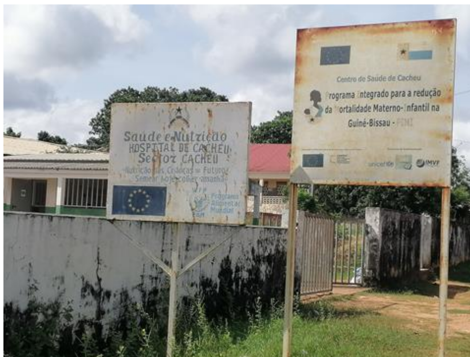
Figura 48 – Fachada da entrada do Centro Materno Infantil
