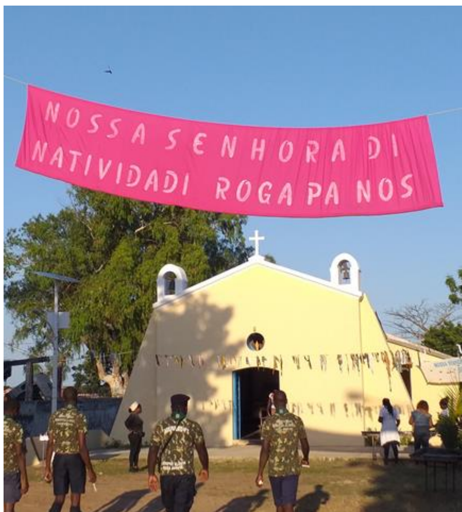
Figura 41 – Fachada da Capelinha
