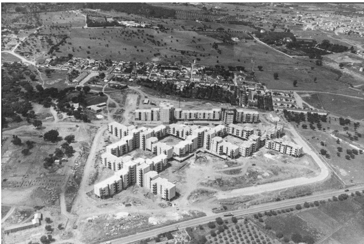
Figura 18: Vista aérea sobre a área de expansão oeste da cidade da Évora, com Bairro da Cruz da Picada e Bairro de Santa Maria na parte central da imagem. Fonte: Drawing Matter Collections, Arquivo Álvaro Siza, 1977. Publicado por Malagueira.pt, 2020
