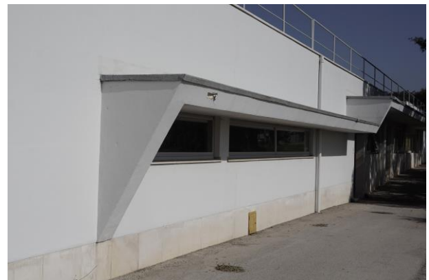
Figura 115: Escola Superior de Educação de Setúbal (1986 - 1992), de Álvaro Siza. Alçado com pala de sombreamento sobre as aberturas do rés-do-chão. Fonte: Autor, 2022
