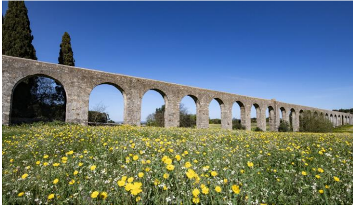
Figura 24: Vista panorâmica da paisagem com o Aqueduto da Água de Prata de Évora. Fonte: CM-Évora, 2023
