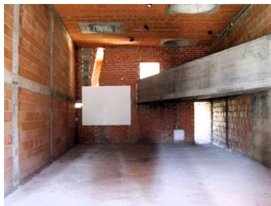
Figura 123: Edifício Dimensione Fuoco San Doná di Piave, Itália (1993), de Álvaro Siza. Vista do interior. Fonte: Entre ESC, (s.d.).
