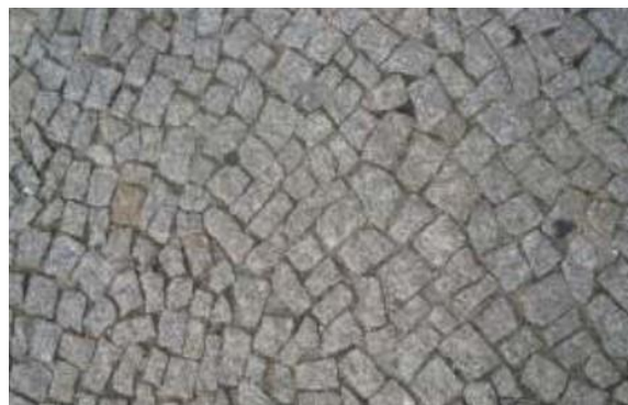
Figura 97: Calçada tradicional miúda de granito. Fonte: CM-Évora, 2015
