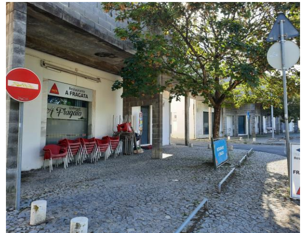
Figura 27: Conduta principal, colocada ao longo do eixo este-oeste, formando um pórtico para áreas comerciais e de serviço. Fonte: Autor, 2023
