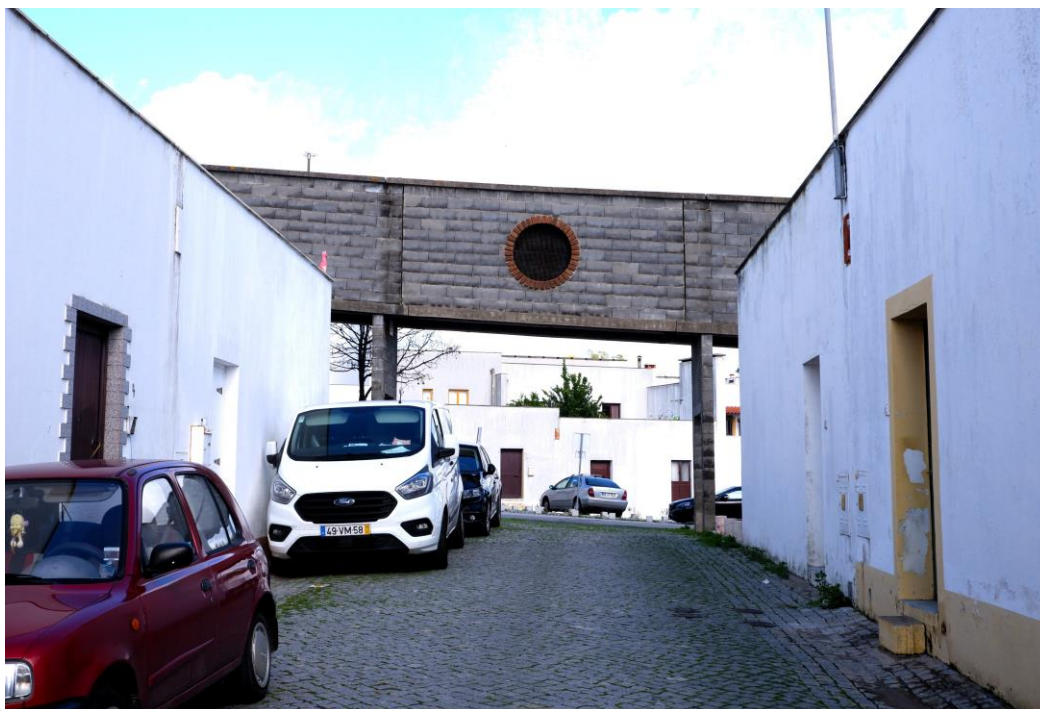
Figura 82: “Pórtico monumental” formado pela conduta aérea no cruzamento da via distribuidora do conjunto habitacional e área pública central. Fonte: Autor, 2023
