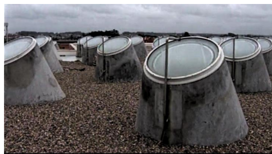
Figura 121: Biblioteca da Universidade de Aveiro (1988 – 1993), de Álvaro Siza. Vista sobre cobertura. Fonte: RTP Arquivos, 1995
