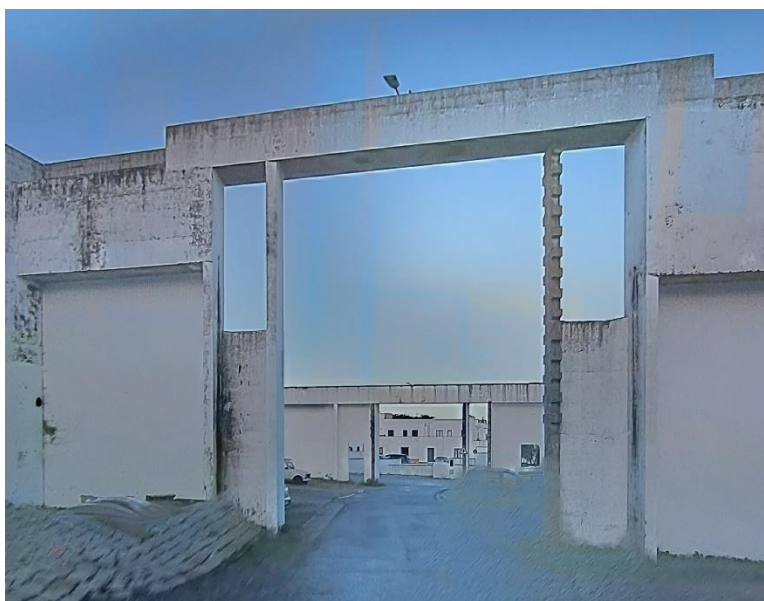
Figura 83: Sucessão de pórticos, formadas pela conduta aérea, que demarcam a Rua do Túnel. Fonte: Autor, 2023
