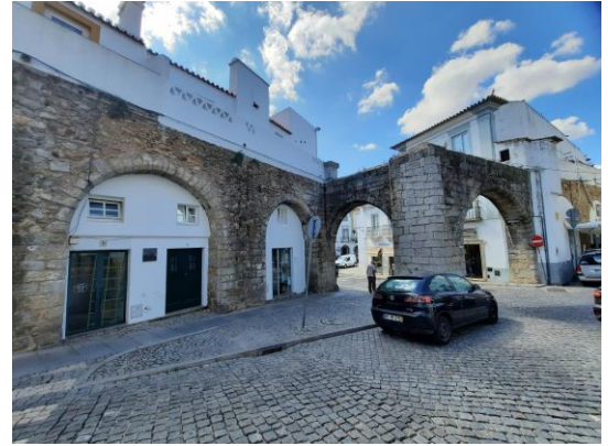
Figura 25: Vista para os edifícios e ruas da cidade de Évora, que se alinham em relação a estrutura do Aqueduto da Água de Prata. Fonte: Autor, 2023
