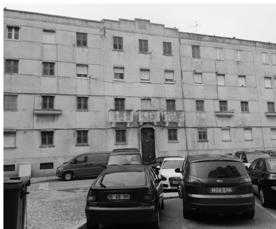
Figura 59: Fachada principal do “Prédio Viola” na Rua Dr. Carlos Manuel Saudade e Silva. (Ana Rita Jesus, 2022).
