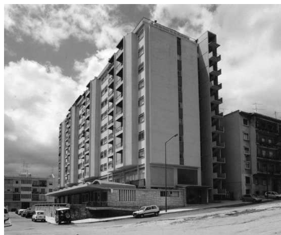
Figura 104: Vista exterior do edifício. Fundación Docomomo Ibérico
