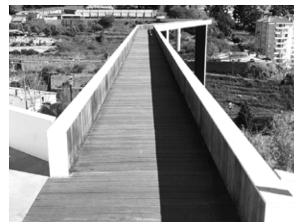
Fig. 57. Ponte sobre a Ribeira da Carpinteira.
