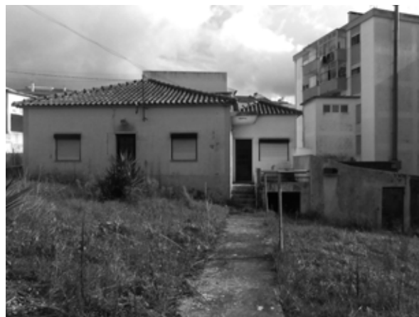
Fig. 69. Edifício existente de apoio para a horta.
