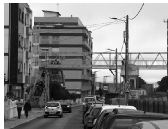
Fig. 53. Ponte sobre a estação de comboios.
