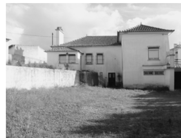
Fig. 68. Edifício existente mantido para convidados.
