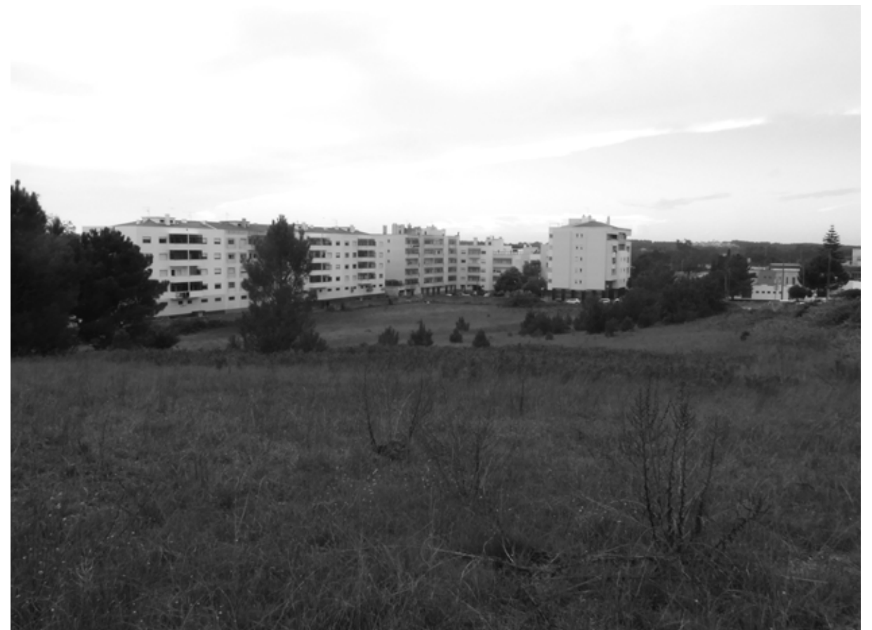
Fig. 46. Vista do terreno pela sua cota altimétrica mais alta (42 m).
