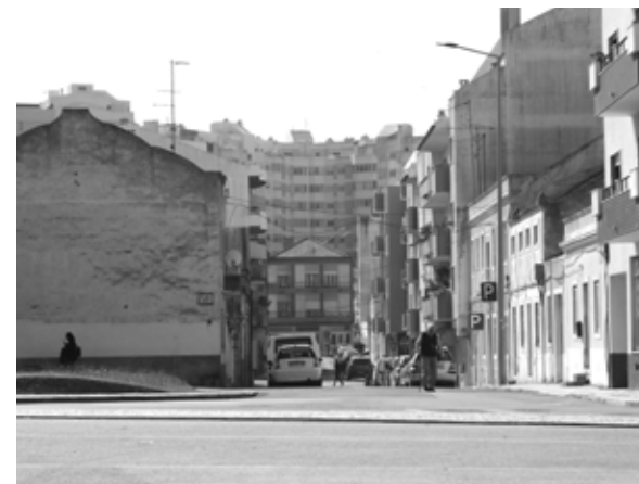
Fig. 35. Descontrole da escala do edificado.
