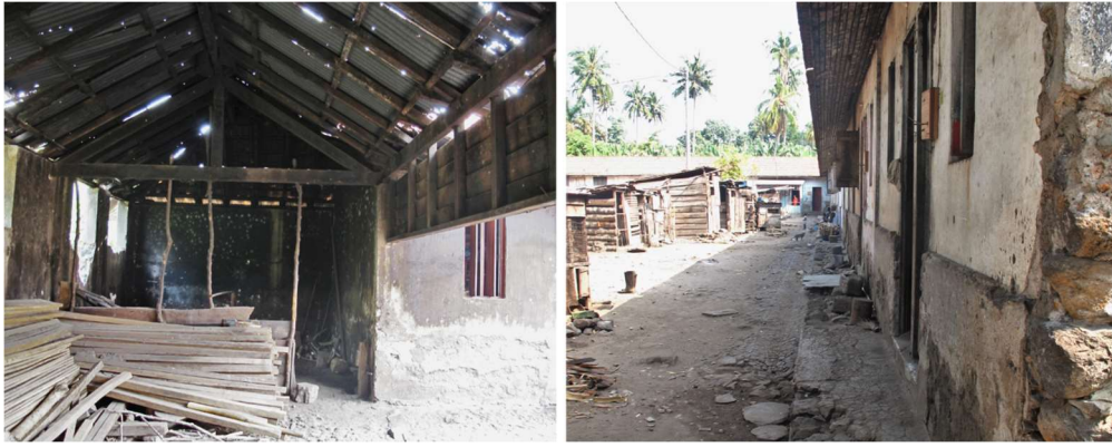
Figura 50 – Estrutura da cobertura e sistema de drenagem das águas pluviais na roça Fernão Dias. (Silva, 2016)
