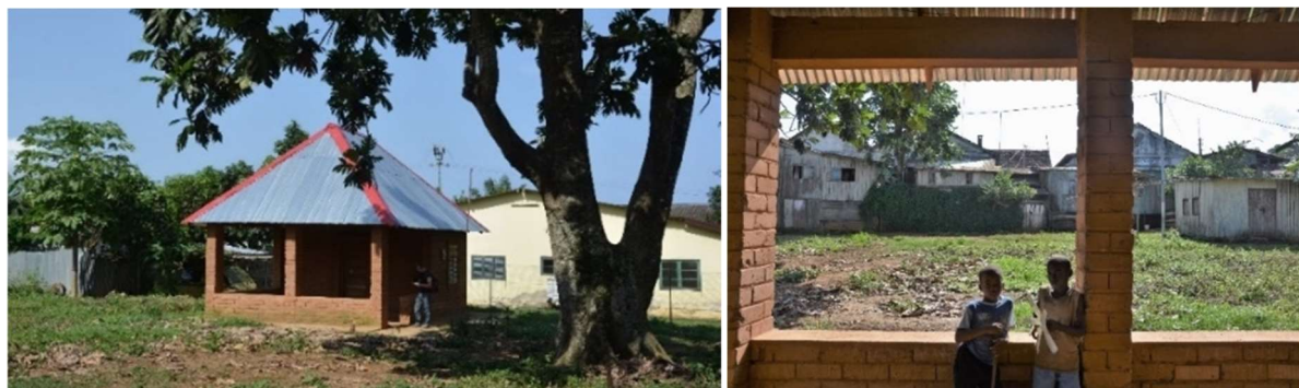
Figura 34 – Construção em tijolos de adobe e cobertura em chapa metálica, roça Água Izé (2021).
