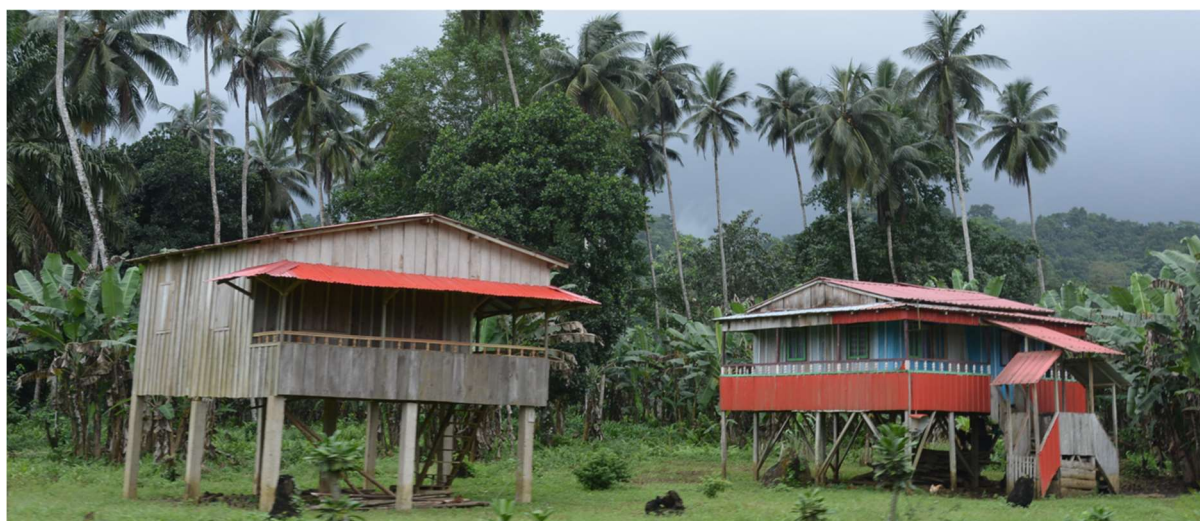
Figura 35 – Habitações palafita construídas em madeira, próximas da roça Porto Alegre, ilha de São Tomé (2021).
