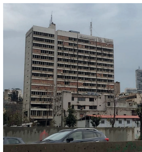
73. Edifício da EDL pós explosão, Inspireli.
