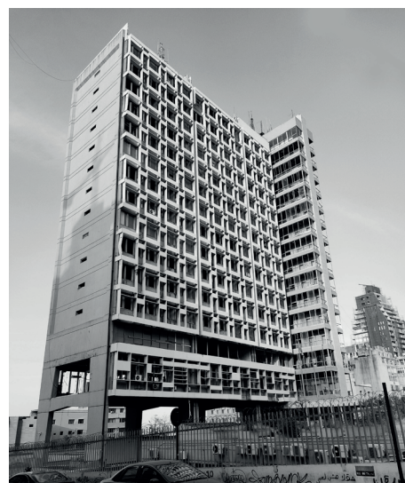
39. Edifício de administração da companhia de eletricidade do Líbano, Luísa Sarmento, 2021.
