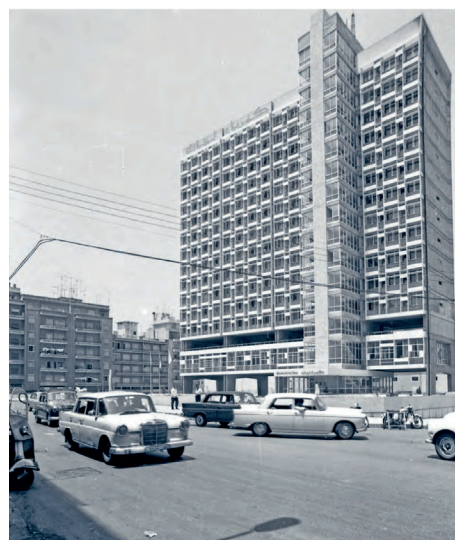
78. O edifício em 1971, Arab Center for Architecture.
