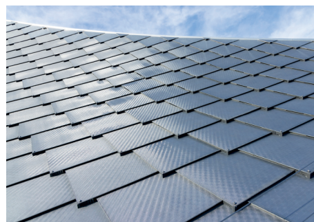
97. Cobertura do Google Bay View Campus com telhas fotovoltaicas, Iwan Baan.
