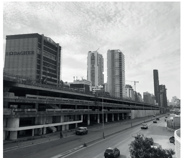
31. Estação de autocarros abandonada na Charles Helou, Carlota Garcez, 2021.
