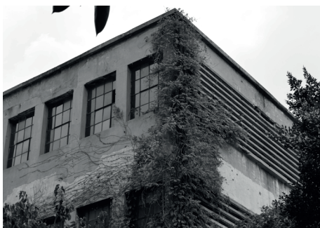
37. Exterior da fábrica, Adriana do Carmo, 2021.
