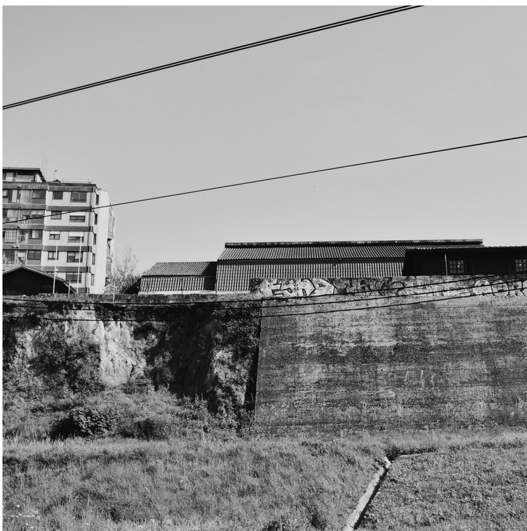
Figura 50 – Salão do Centro Paroquial de Matosinhos no topo do talude, 2022. Fonte: Mariana Brito.
