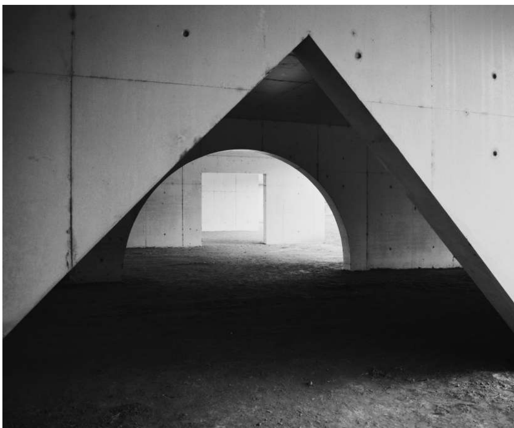
Figura 53 – As lâminas estruturais do piso térreo do Museu Nadir Afonso, 2021. Fonte: Bernardo Vicente,
