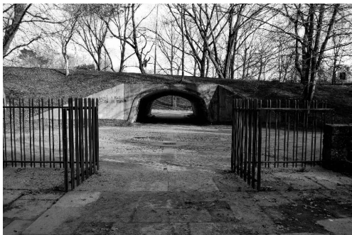
Via de acesso à A28 em Leça da Palmeira e túneis de ligação à Quinta da Conceição
