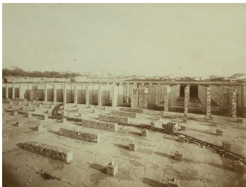
FIG.16 Construção Reservatorio Campo do Ourique
