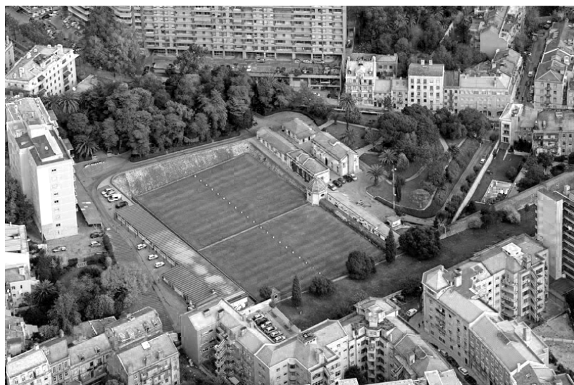
FIG.39 Vazio urbano, Reservatório do Campo Ourique, antigamente
