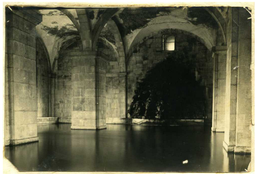
FIG.15 Interior do Reservatório da Mãe d'Água das Amoreiras
