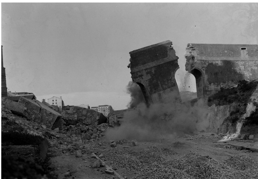
FIG.23 Demolição do troço do aqueduto das Águas Livres na zona das terras de Santana, para a abertura da avenida Infante Santo
