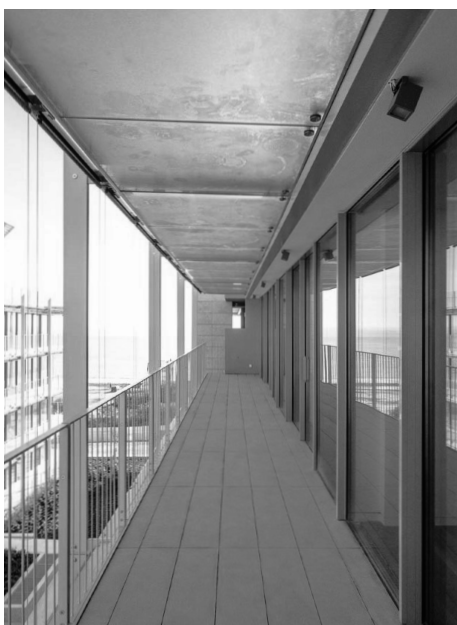
16 Varanda de uma habitação. (Jorge Figueiras, 2020)
