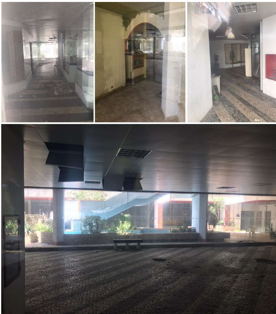
Figura 31 – Interior do Centro Comercial Silcentro, fotografia actual, ano 2021. Fonte: Autor
