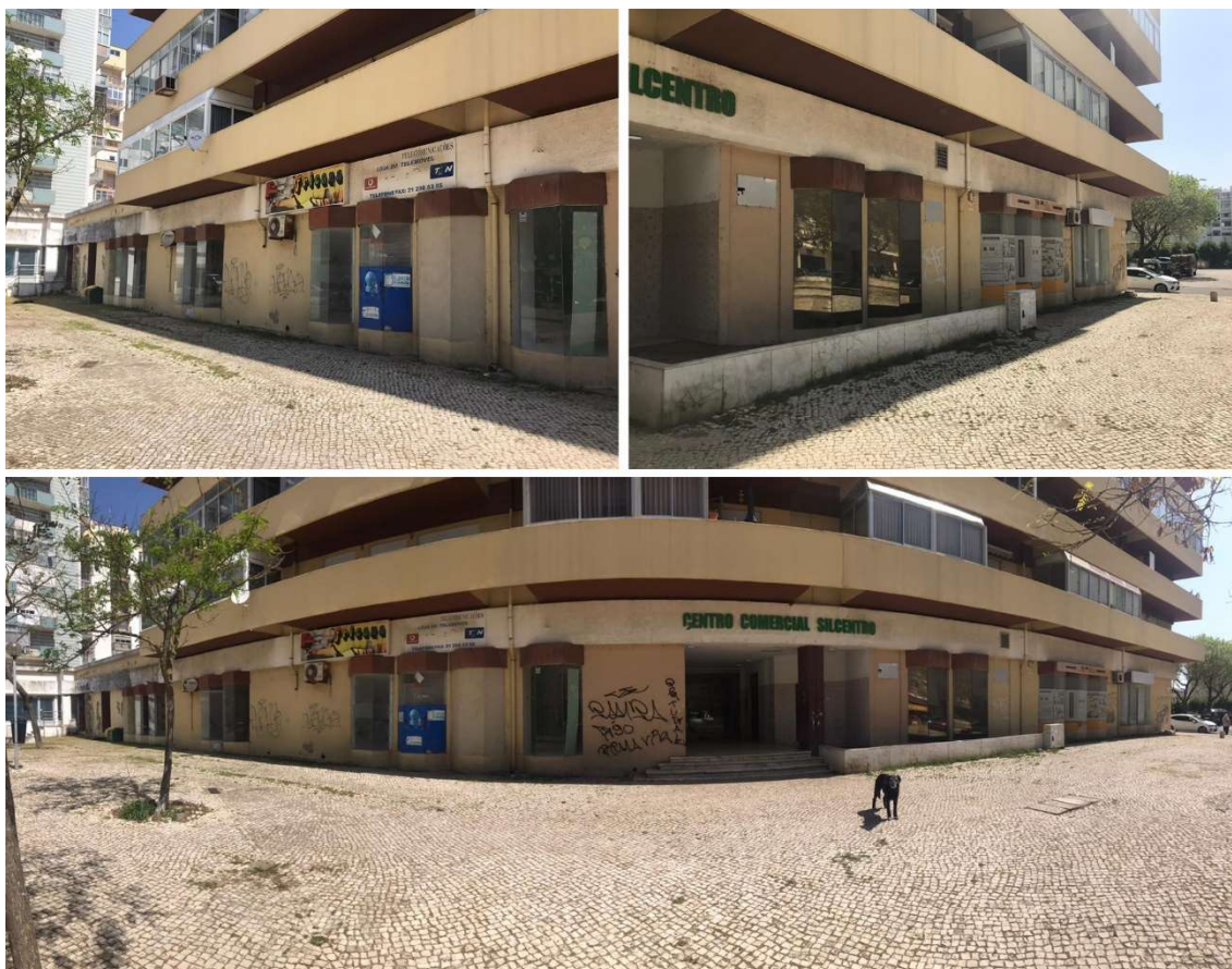
Figura 30 – Fachada Sul e Nascente do Centro Comercial Silcentro, fotografia feita a partir da Rua Juncal e da Rua Ercílio Costa, fotografia actual, ano 2021. Fonte: Autor
