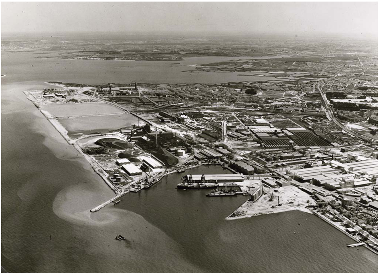
Figura 44. Vista aérea complexo industrial CUF Barreiro. Fonte: https://alfredodasilva150anos.pt/o-barreiro-criado-por-alfredo-da-silva/
