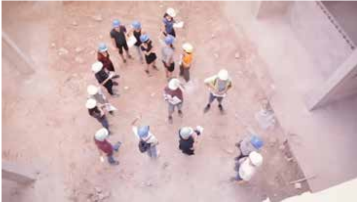
2. Início da construção.
