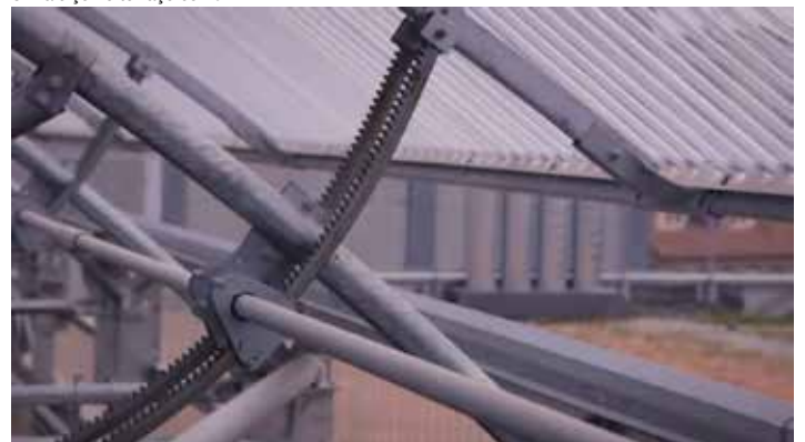
9. Sistema mecânico de ventilação através da cobertura.
