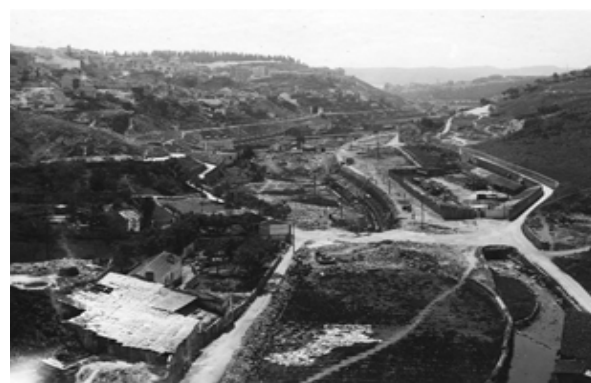
Figura 1.17 - Vale de Alcântara, vista tirada do viaduto Duarte Pacheco. Obras de encanamento da ribeira de Alcântara em 1945.
