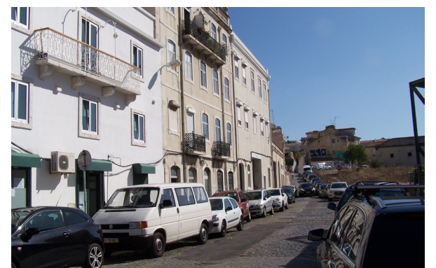
Figura 3.03 - Fotografia sobre Rua do Arco a Alcântara
