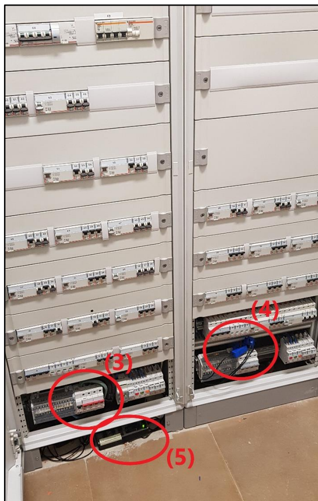
Figura 24 - Sensores em funcionamento e a transmitir dados para o sistema GEEP.
