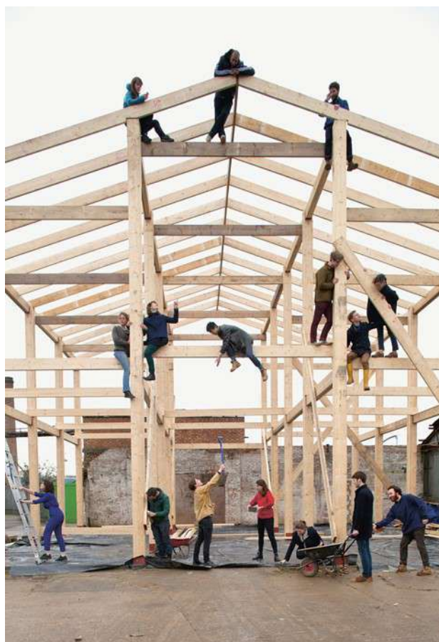
Figura 2.5 - membros do Assemble durante a construção do “Yardhouse Studios”
