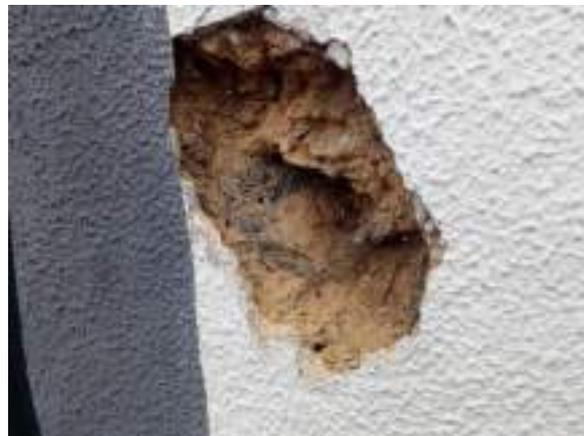
*Figura 35 e 36 - Pormenores de degradação do reboco de terra (Fonte: Marco Andrade, 2019)*
