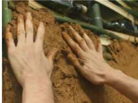
Figura 8 - Construindo uma parede de pau-a-pique (Fonte: Conexão planeta, 2017, Disponível em WWW: <<http://conexaoplaneta.com.br/blog/bioconstrucao-ou-como-construir-uma-casa-com-as-proprias-maos/>>)
