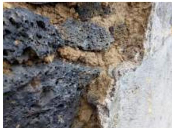
Figura 38 e 39 - Pormenores de degradação do reboco de terra (Fonte: Marco Andrade, 2019)
