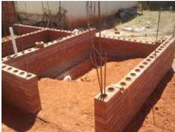
Figura 17 - Montagem dos blocos de terra comprimidos
