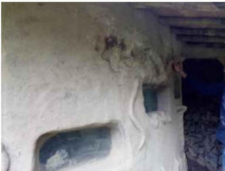
*Figura 62 - Manchas na parede exterior (Fonte: Marco Andrade, 2019)*
