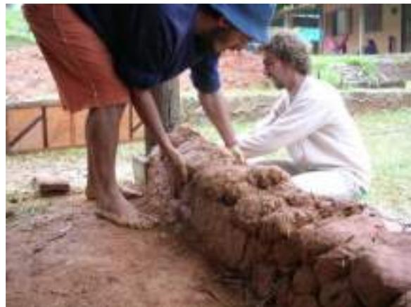
Figura 15 - Modulação manual dos "pães" de terra crua (Fonte: Sítio Abaetetuba, 2010, Disponível em WWW: <<http://permaculturarj.blogspot.com/2010/02/bioconstruca-o-no-sitio-abaetetuba.html>>)
