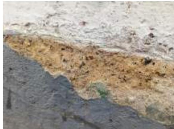
*Figura 32 e 33 - Pormenores de degradação do reboco de terra (Fonte: Marco Andrade, 2019)*
