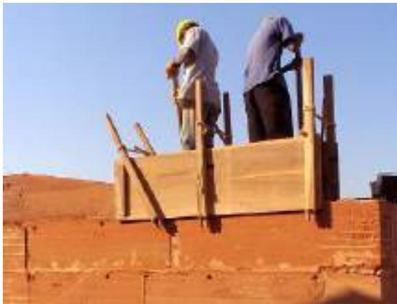
Figura 16 - Compressão manual da terra em moldes de madeira (Fonte: Miguel Mendes, 2006, Disponível em WWW: <<http://arquitecturasdeterra.blogspot.com/2008/10/textoa-construo-com-terra-em-portugal.html>>)
