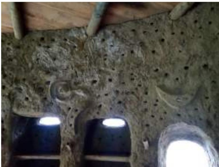
*Figura 61 - Surgimento de fissuras no interior, junto às varas (Fonte: Marco Andrade, 2019)*
