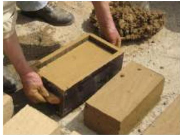
Figura 19 - Moldagem dos blocos (Fonte: Assim que faz, Disponível em WWW: <<https://www.assimquefaz.com/faca-voce-mesmo-a-sua-casa-parte-iii-adobe-a-tecnica-de-construcao-natural/>>)
