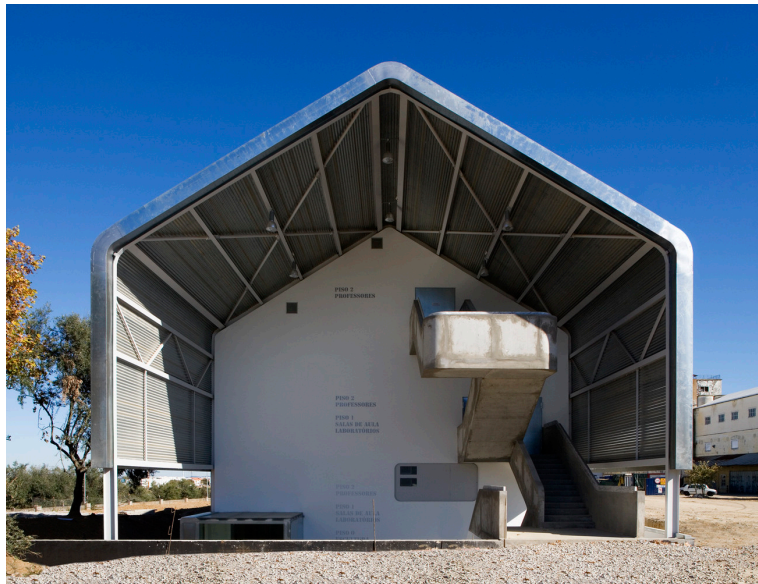
Figura 17- Antiga Fábrica “Os Leões” refuncionalizada para um polo de Artes e Arquitetura da Universidade de Évora.
