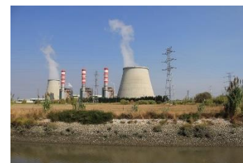
Central Termo Elétrica, vista da Vala
