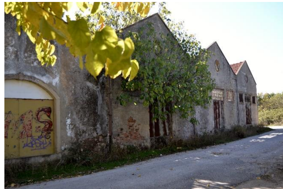
Levantamento Fotográfico do Exterior
