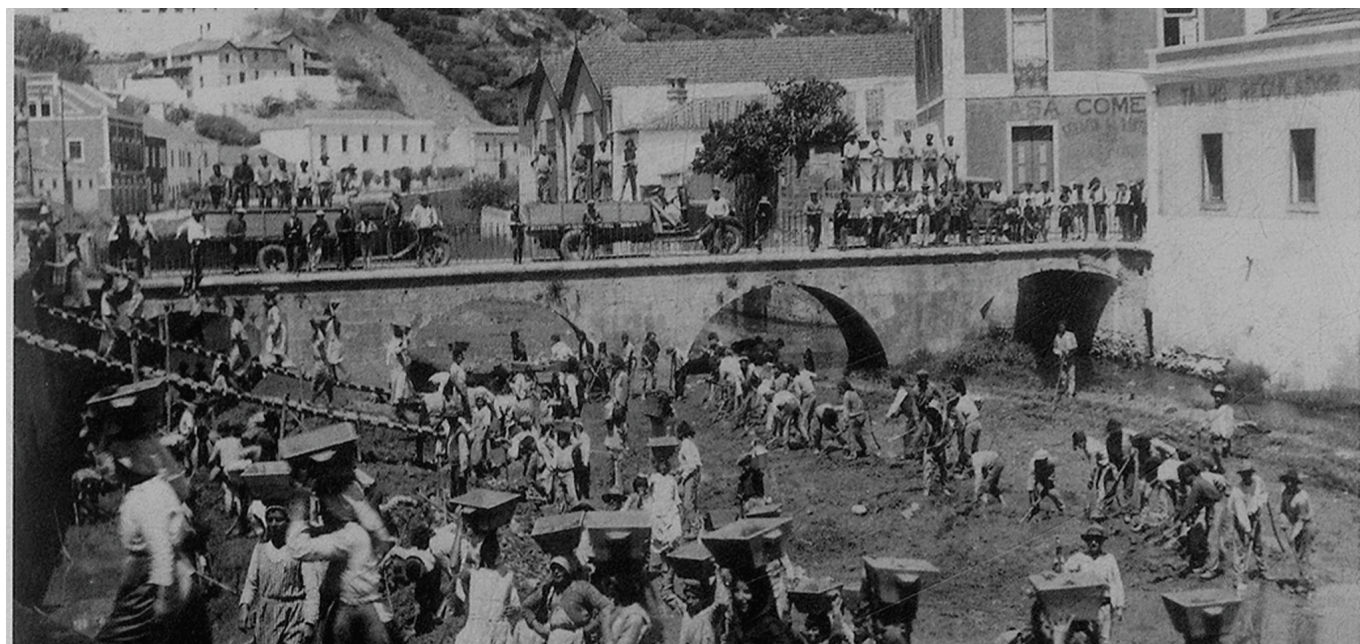
Imagem 14 - Limpeza do rio abaixo da Ponte do Espírito Santo [1935]
