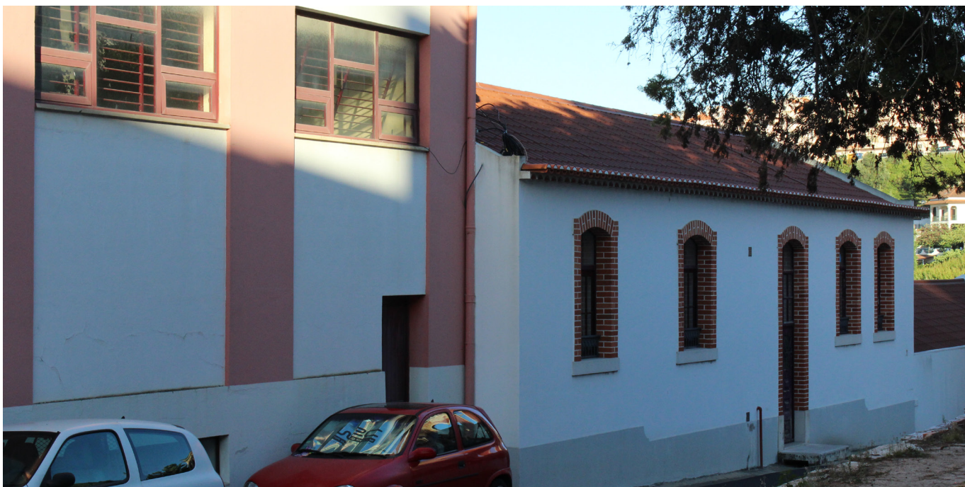
Imagem 57 - Fachada Sudoeste - Ginásio e Creche.
