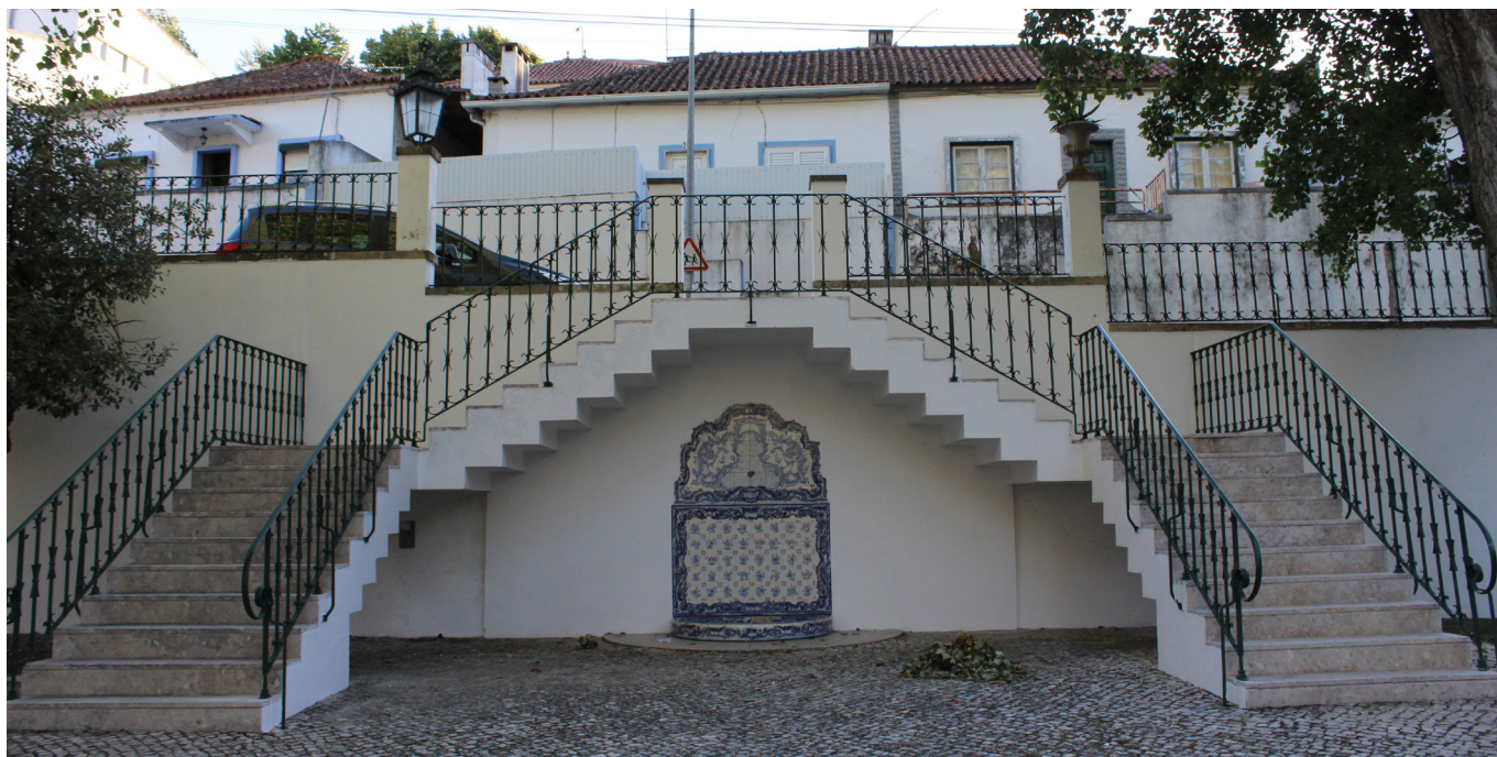
Imagem 55 - Escadaria do Jardim Vaz Monteiro.
