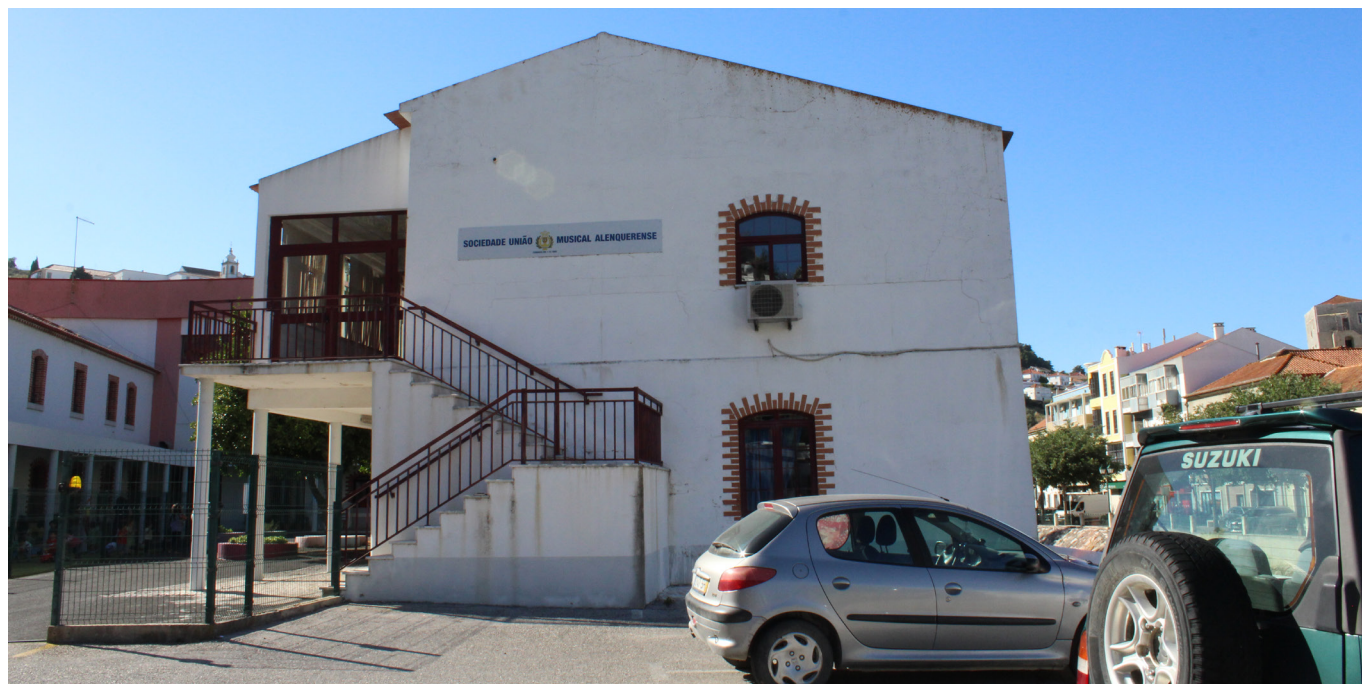
Imagem 47 - Fachada a Sul - S.U.M.A.
