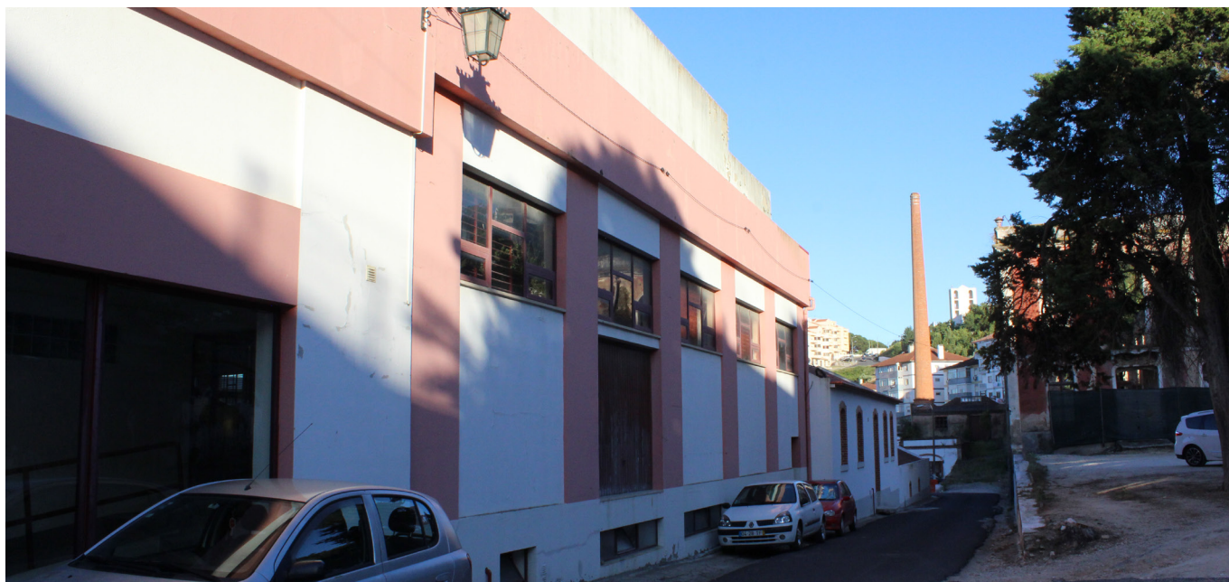
Imagem 56 - Fachada Sudoeste - Ginásio e creche.
