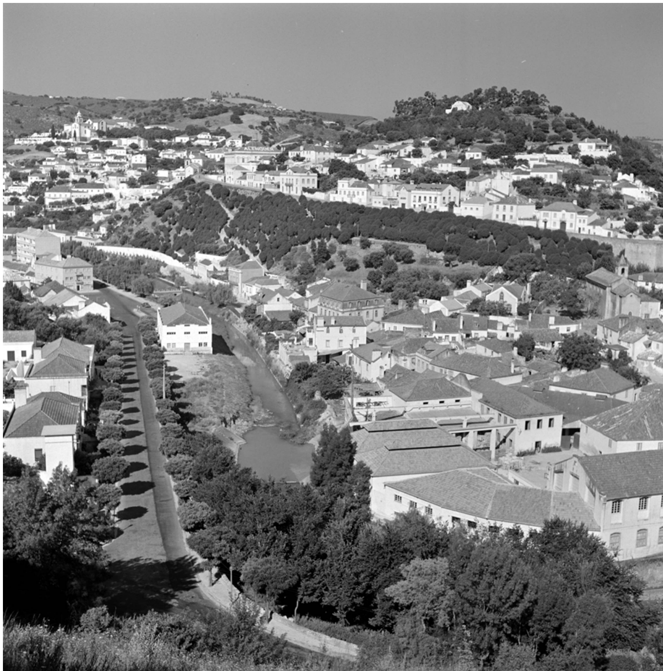
Imagem 10 - Panorâmica de Alenquer, edifício do Sporting Clube de Alenquer na margem esquerda da ribeira [1955 - 1970]
