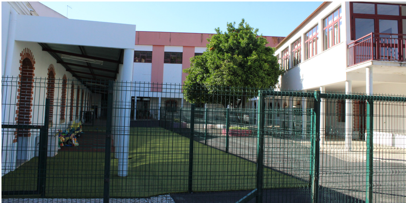
Imagem 39 - Vista da fachada orientada a sul. Recreio exterior da creche e pátio comum do edifício.
