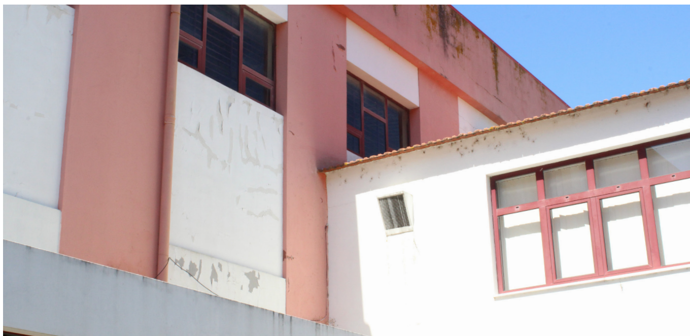
Imagem 44 - Junção do edifício antigo com o edifício mais recente.
