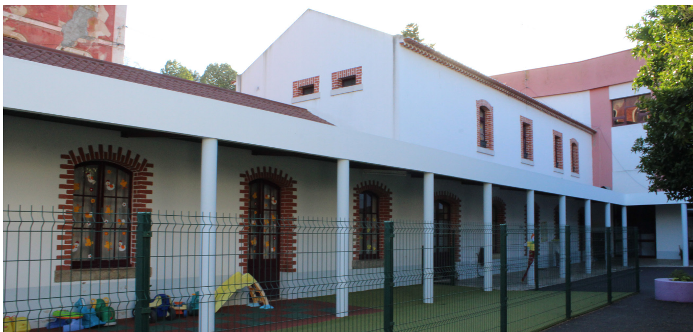
Imagem 38 - Fachada da Creche - interior do pátio. Área de recreio exterior da creche.
