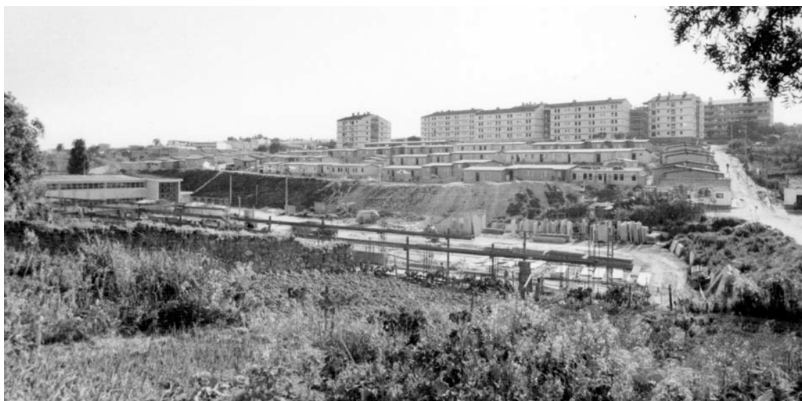
Figura 15 - O estaleiro de construção do Bairro PRODAC, montado durante as obras, onde os moradores iam buscar os materiais para a autoconstrução
