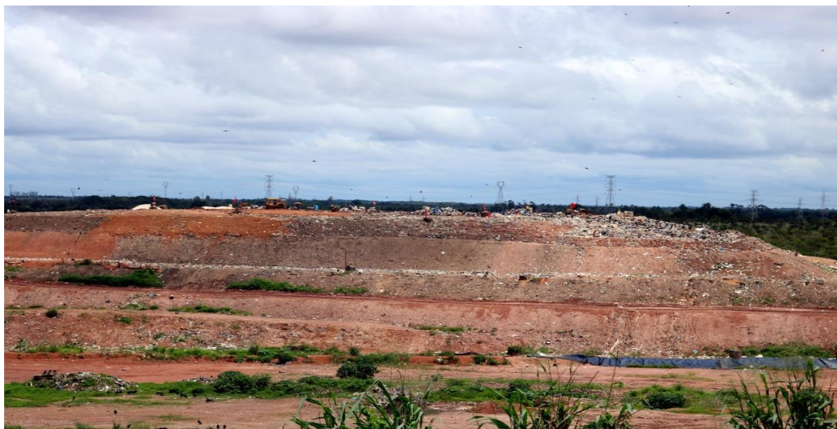
Imagem 17: Aterro sanitário de Macapá, Macapá/AP
