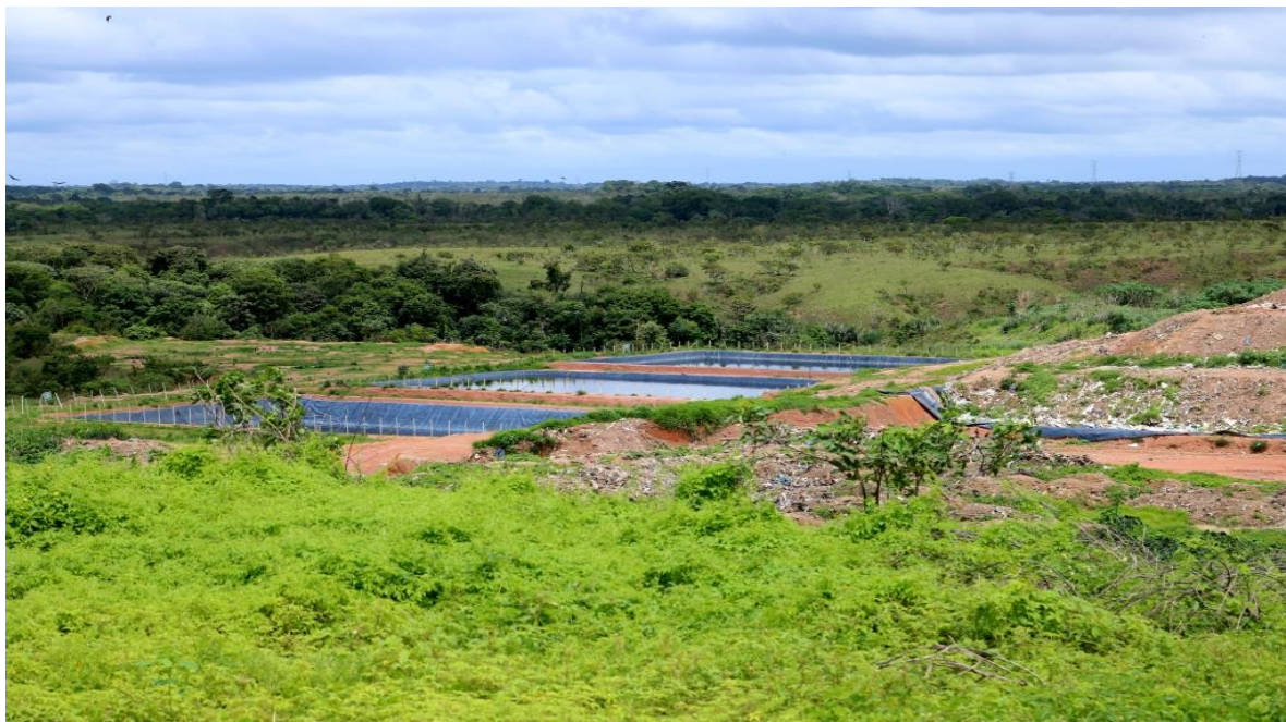
Imagem 16: Aterro Sanitário de Macapá, Macapá/AP
