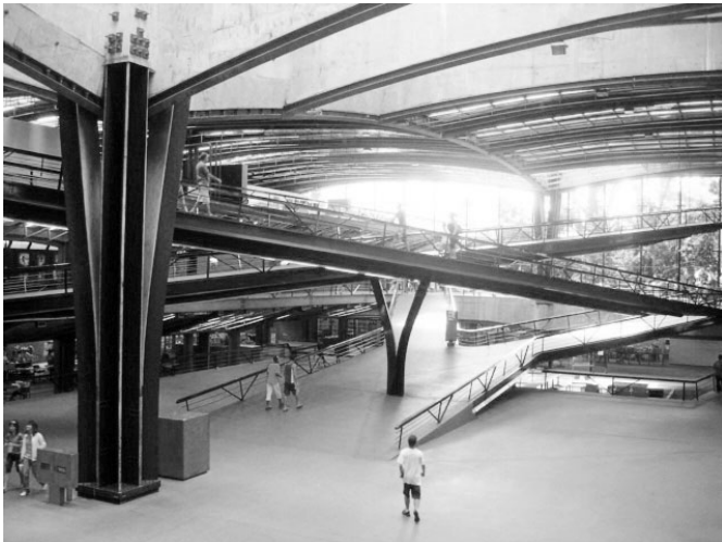
Fig. 53 Foto Sala Interna CCSP
