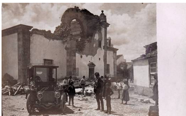
A igreja de Benavente em ruína, que seria depois demolida. (AN)
