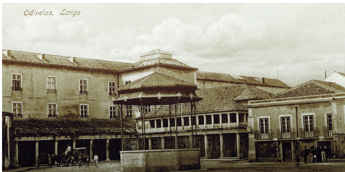
Img 101 e 102 - Fotografias antigas da perspetiva exterior da zona da Capela e do largo de entrada do Mosteiro de D. Dinis
