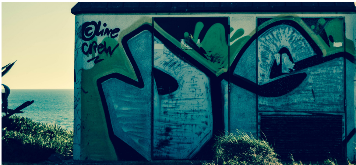
Img 24 - Um graffit na marginal de Lisboa, numa instalação de eletricidade pública.
