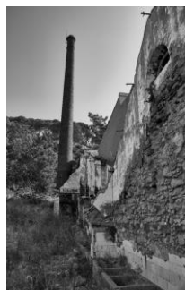
Figura 14: Número 37 - Chaminé e parede da fábrica de Conservas São Pedro. (Freguesia de S. Sebastião, Concelho e Distrito de Setúbal)
