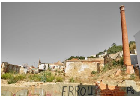
Figura 8: Número 35 - Fábrica de conservas Bella Vista. (Freguesia de São Sebastião, Concelho e Distrito de Setúbal)
