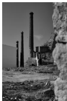
Figura 13: Números 35 e 54 - Chaminés das fábricas de conservas, Bella Vista, não identificada e Estrela do Sul. (Freguesia de São Sebastião, Concelho e Distrito de Setúbal)
