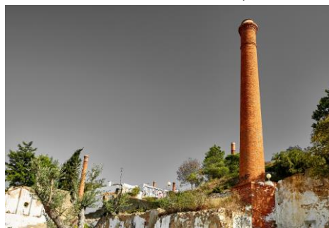
Figura 11: Chaminés de algumas fábricas de conservas. (Freguesia de São Sebastião, Concelho e Distrito de Setúbal)
