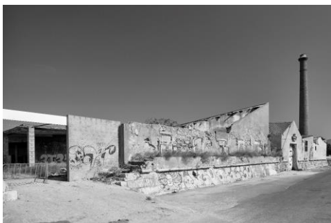
Figura 10: Número 21 e 55 - Fábrica de conservas Aurora, chaminé e edifício da fábrica de conservas Gargalo (direita). (Freguesia de Nossa S. da Anunciada, Concelho e Distrito de Setúbal)
