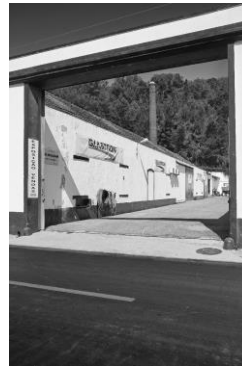
Figura 3: Número 51 - Chaminé e edifício da fábrica de conservas Gizela. (Freguesia de Nossa Senhora da Anunciada, Concelho e Distrito de Setúbal)
