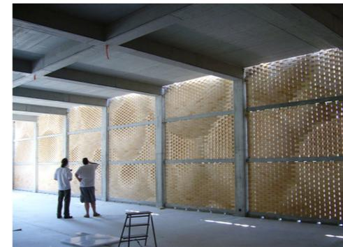
FIG. 21 Fachada do Gantenbein Vineyard (2006) instalada através de módulos construídos com um braço robótico
