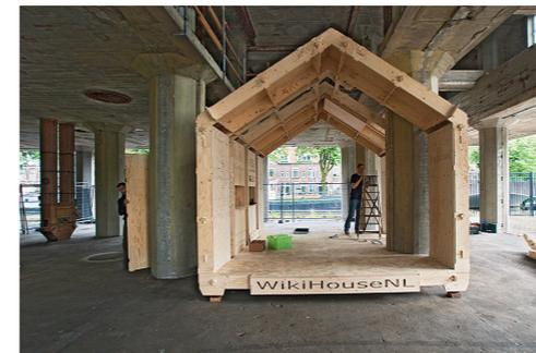
FIG. 33 Versão do sistema da Wikihouse pela Wikihouse Nova Zelândia
