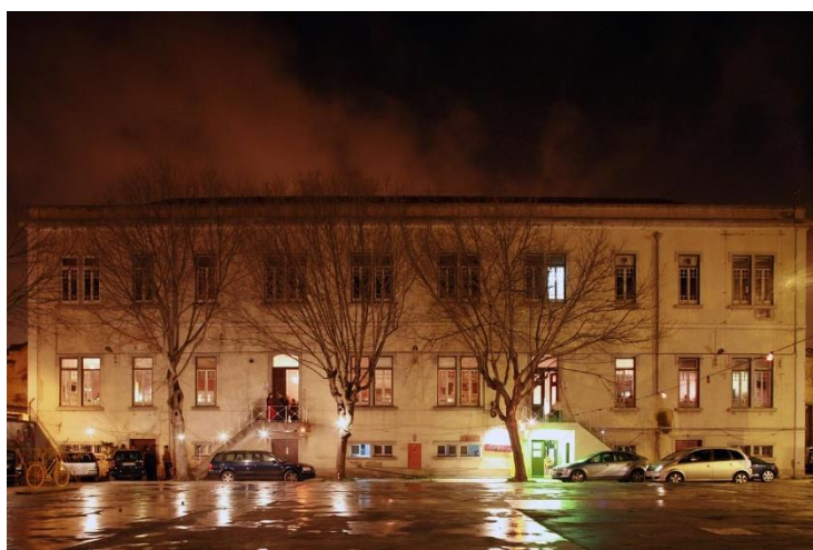
Figura 7-1 Edifício onde se encontra atualmente a Fábrica Braço de Prata, outrora os escritórios da antiga Fábrica de Material de Guerra do Braço de Prata 149 .
