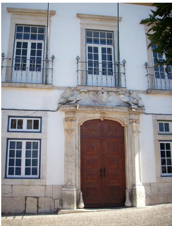
Fig. 21 - Idem , portal principal, pormenor da cantaria. Foto: Carlos Filipe, 2012.
