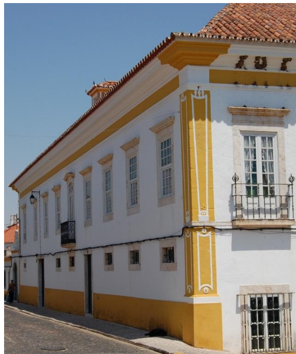
Fig. 28 - Idem , cunhal fingido em argamassa. Foto: Carlos Filipe, 2013.
