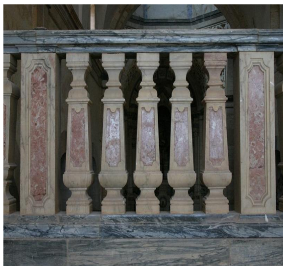
Fig. 9 - Idem , secção da balaustrada, balaústre com mármore creme vergado e pedra Lioz avermelhada. Foto: Paulo Lopes, 2011.
