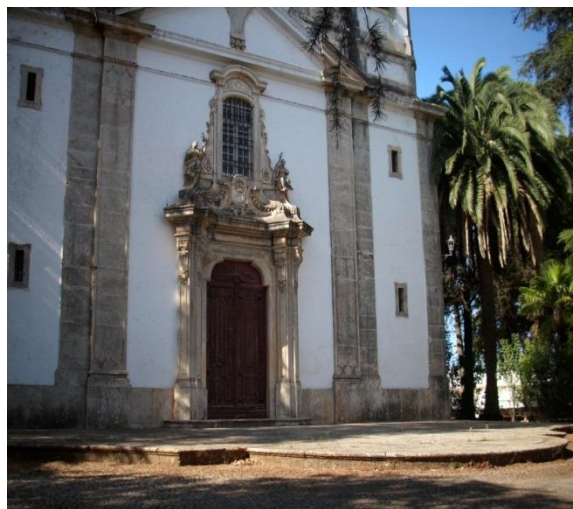
Fig. 34 - Idem , adro fronteiro lajeado em mármore branco. Foto: Carlos Filipe, 2011.
