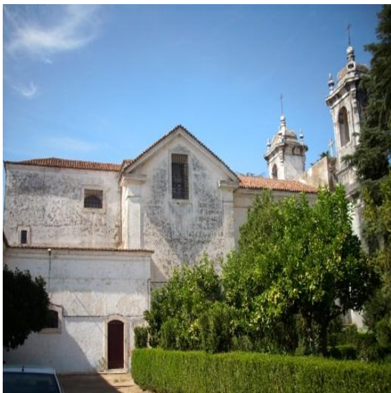
Fig. 37 - Idem , lado sul no jardim em paralelo à Igreja. Foto: Carlos Filipe, 2012.
