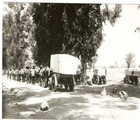
Fig. 52 - O transporte de blocos de mármore em zorras puxadas por pares de bois, Vila Viçosa, Século XX. A imagem digitalizada foi cedida pelo antigo mestre alvanel António José, sendo desconhecida a autoria da fotografia. (Investigação no âmbito do projecto História da Indústria dos Mármore s).
