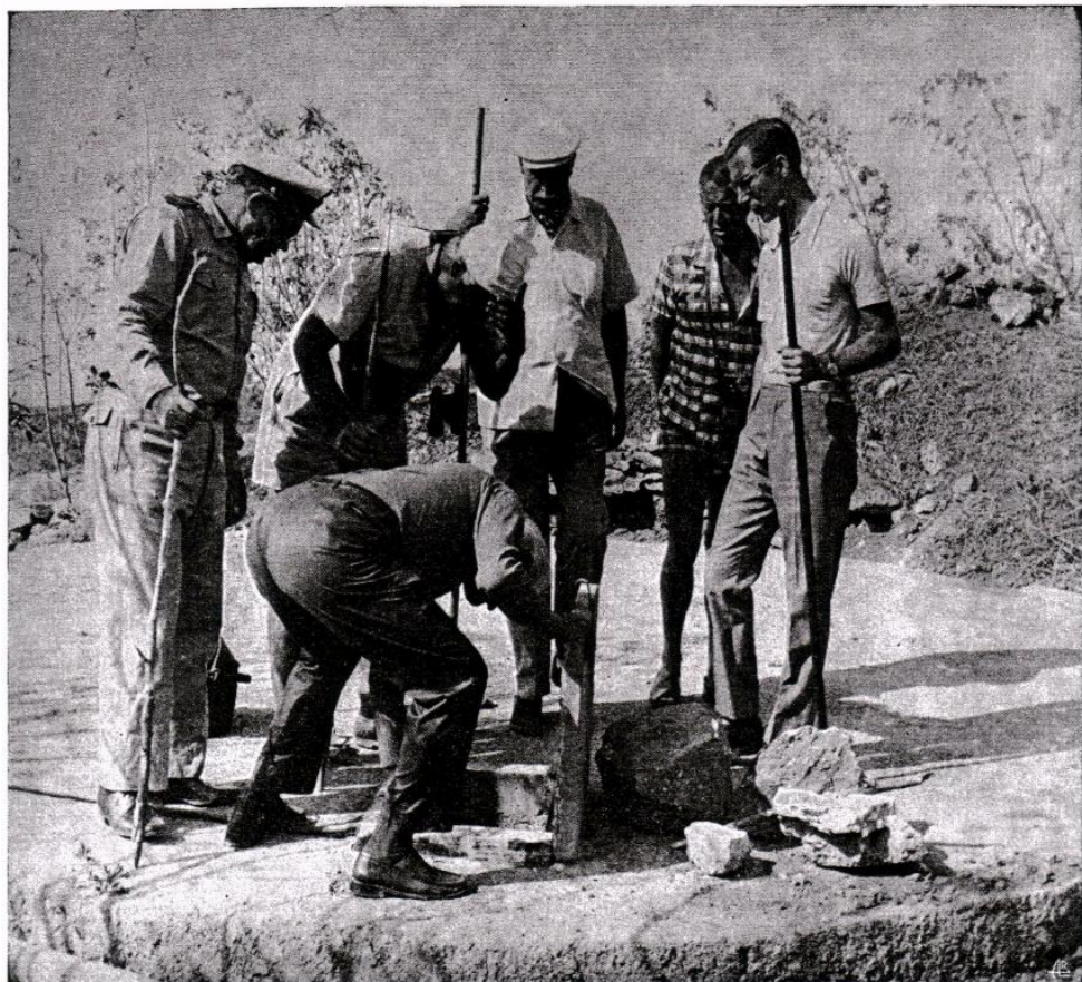
Figura 51 - Visita das autoridades portuguesas à velha cisterna da Selvagem Grande, à época a mais segura e volumosa fonte de abastecimento de água doce, defendida, através de uma laje de cobertura, da inquinação que era provocada pela decomposição de animais que, frequentemente, ali caíam. Foto: Colecção particular de Paul Alexander Zino
