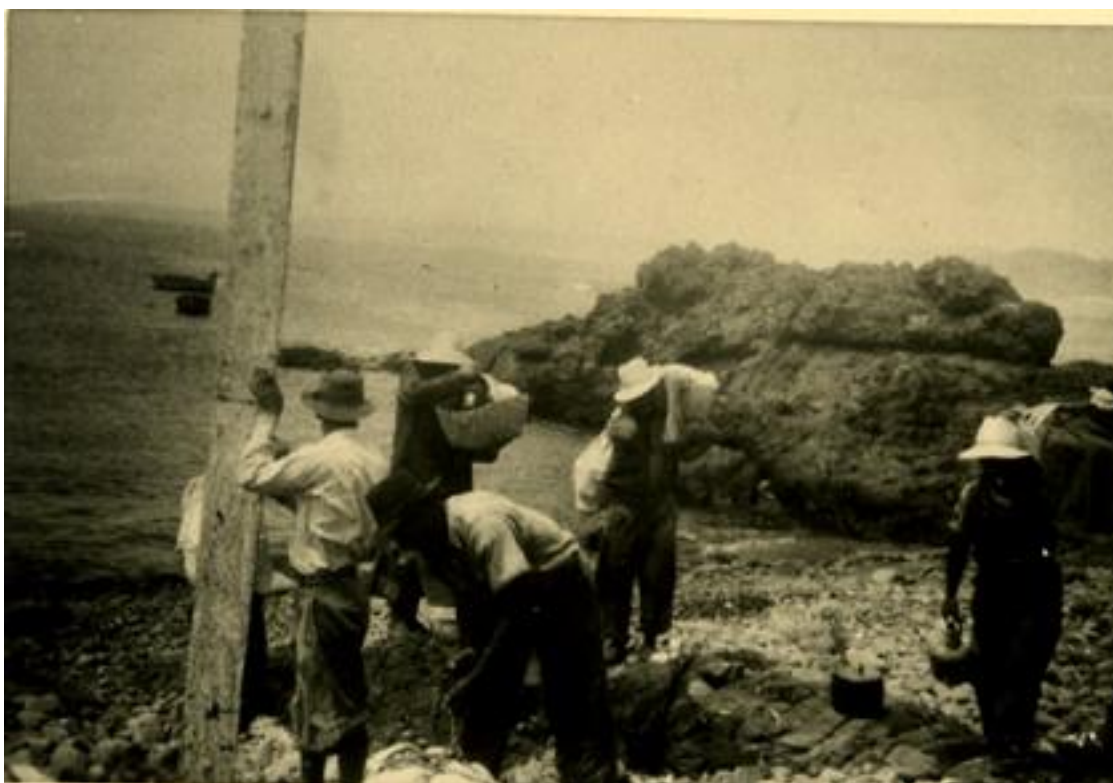
Figura 36 – Trabalhos na Selvagem Pequena. Ano de 1951. Foto: António Augusto Peixoto Correia
