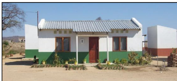
Figura 4.1.2 - Visão geral da habitação modelo de reassentamento
