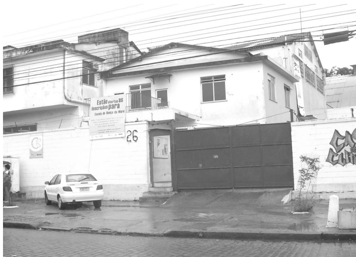
Figura 9.4 Fachada da Casa de Cultura da Maré no Morro do Timbau
