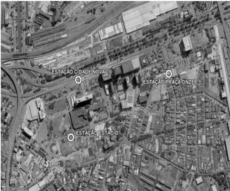
Figure 10.1 Esta foto aérea mostra a pequena distância da Estação Cidade Nova das estações existentes Estácio (aproximadamente 250 metros) e Praça Onze (aproximadamente 500 metros)
