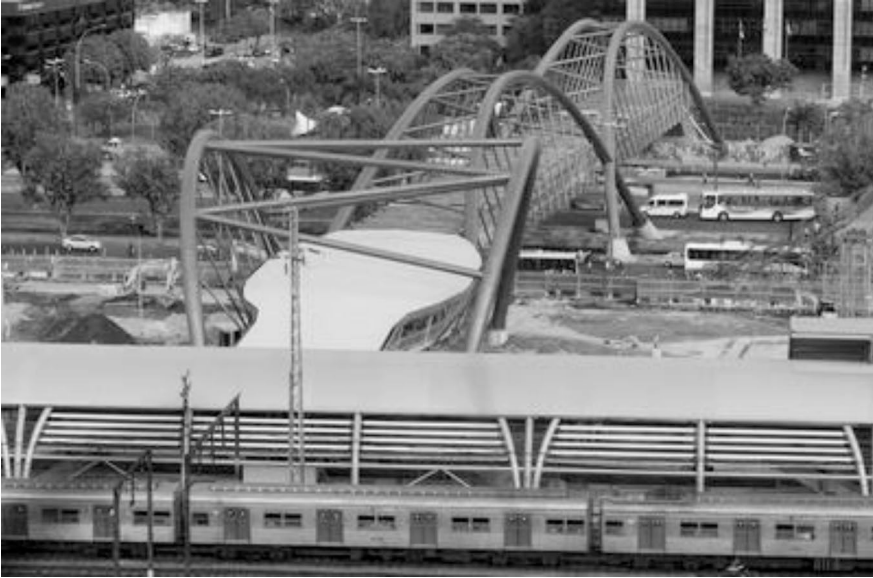
Figure 10.2 Mostra a passarela que interliga a praça em frente a prefeitura à estação de metro Cidade Nova. A passarela está sobre a avenida Presidente Vargas
