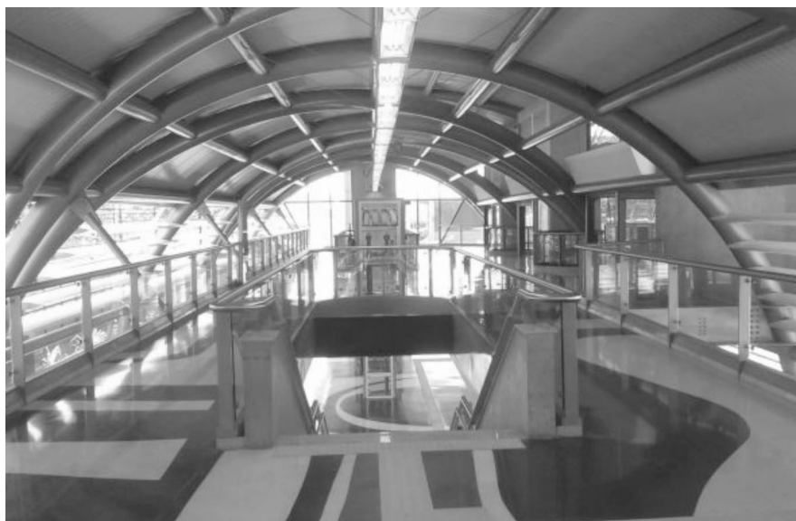
Figure 10.5 Vista do interior da passarela
