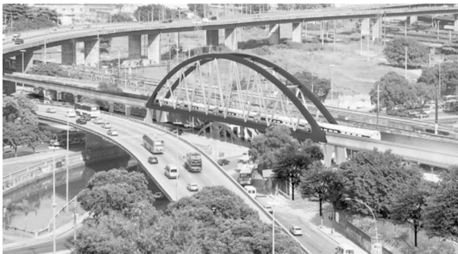
Figure 10.4 Destaque para a ponte da linha do metro, seguindo o novo padrão adotado na passarela e na estação
