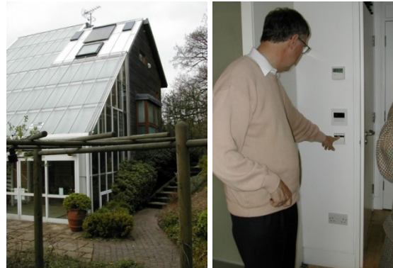
Fig. 8 – O controlo da temperatura é realizado por um sistema domótico com interface na parede dos compartimentos e por comando à distância. Millenium House, projecto Integer, Watford (SE 2004)
