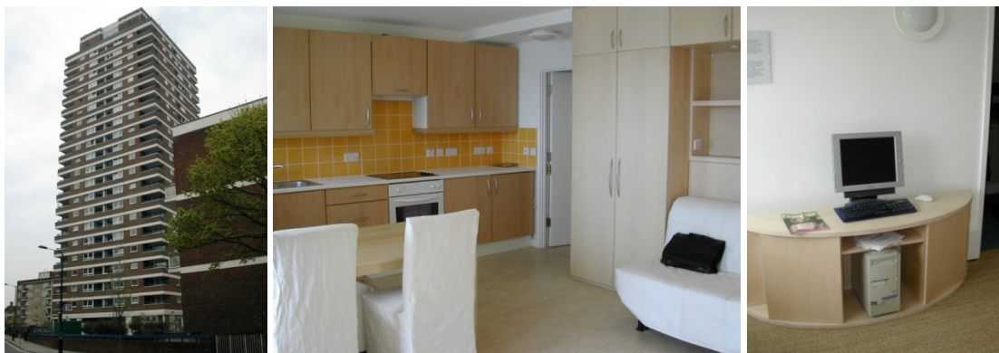
Fig. 22, Fig. 23 e Fig. 24 – Glastonbury House em Westminster. Exterior da torre de apartamento e interior de um fogo após reabilitação. (SE 2004)
