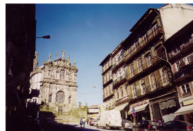
fig. 36 – Edifício da Rua dos Clérigos 76 a 80
