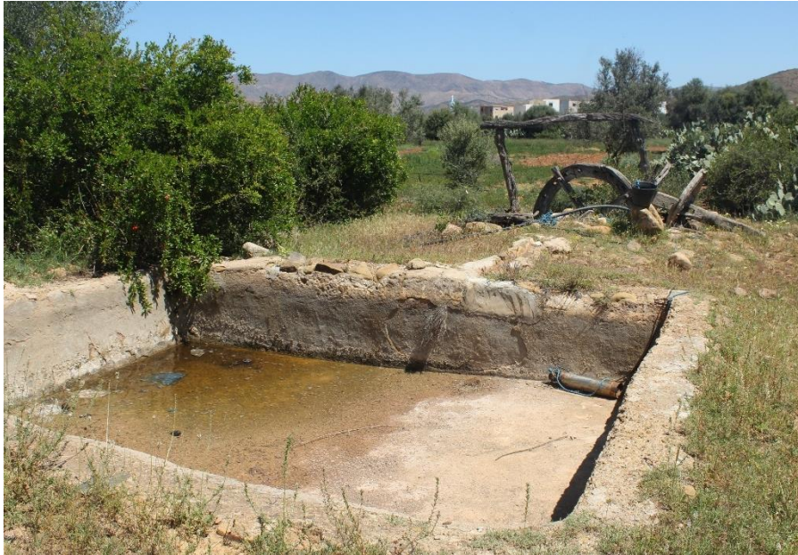
Figura 3 – Vista sobre um conjunto ( mdāra-ndāra ) equipado com uma nora (já muito degradada), Senada, Al-Hoceïma. Fotografia elaborada pelo autor.
