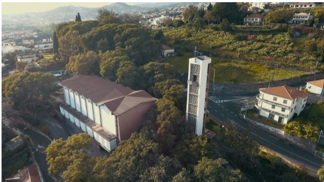
Figura 5 – Vista aérea do edifício da Igreja do Imaculado Coração de Maria e torre sineira. Fonte: Freguesia do Imaculado Coração de Maria promove passeio cultural - atual. 10 fev. 2020. [Consult. 27 jun. 2023]. Disponível em WWW:<URL:https://www.jm-madeira.pt/regiao/ver/83457/Freguesia_do_Imaculado_Coracao_de_Maria_promove_passeio_cultural>.
