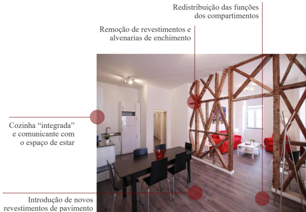
Figura 7 – Alojamento Local na Praça Duque da Terceira. Elaboração dos autores, a partir de registo fotográfico da plataforma Booking , consultado a 28 de junho de 2023.
