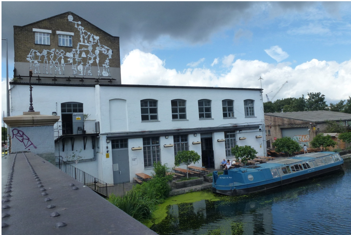
Figura 148. Vista do edifício “The White Building” foi um espaço de dinamização cultural e criativa, dinamizado entre 2012 e 2017 pela SPACE STUDIOS em parceria com a Olympic Park Legacy Company (hoje LLDC), onde foram desenvolvidas residências, projetos e workshops, com o objetivo de criar um espaço aberto à experimentação sobre o tema Arte e Tecnologia. De acordo com a SPACE, o objetivo foi o de estabelecer uma plataforma que pudesse dar suporte e promover a comunidade criativa de HWFI, ligando-a ao Parque Olímpico (Ver: https://spacestudios.org.uk/the-white-building/ ). Hoje neste espaço funciona uma fábrica de cerveja artesanal e pizzaria, a “Crate Brewery & Pizzeria”. Foto: Cláudia Antunes, agosto 2019.
