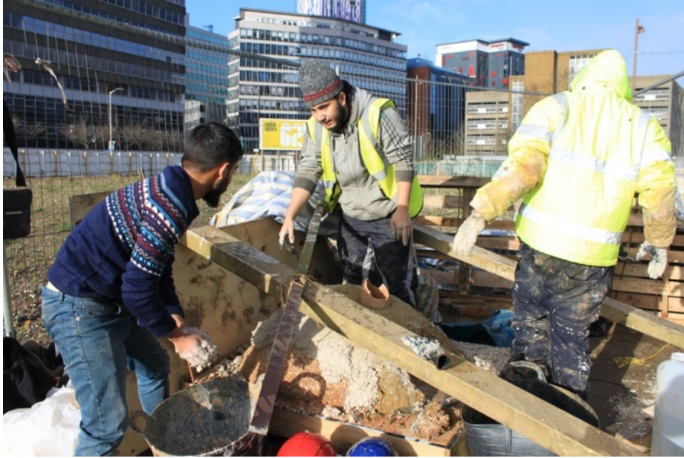
Figura 104. Festival of Toil. Imagem da construção de um forno de barro a partir de terra retirada do estaleiro de obra. Foto: arquivo muf architecture/art.
