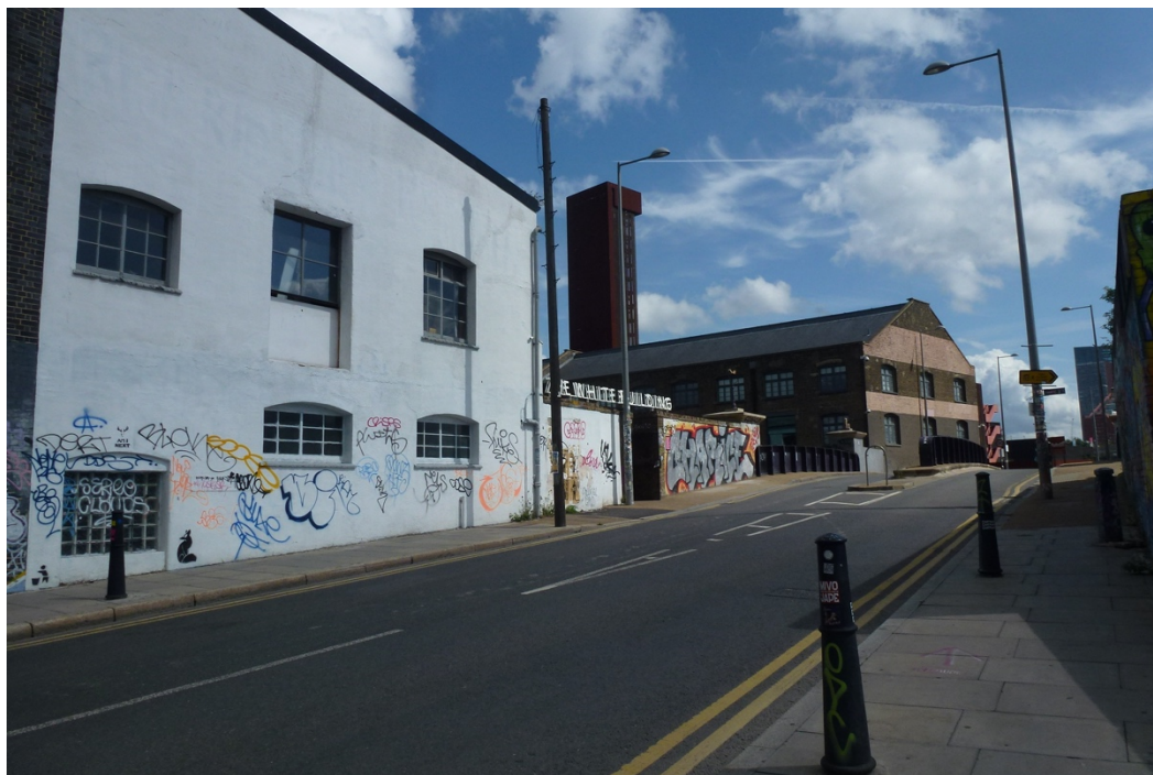
Figura 147. Vista d área de conservação de White Post Lane, que inclui o edifício “White Building”, a ponte “Carpenter’s Road Bridge e o edifício “Queens Yard and Kings Yard/ Energy Centre” (ao fundo). Foto: Cláudia Antunes, agosto 2019.
