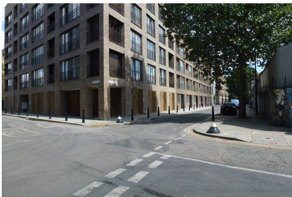
Figura 152. Vista dos novos edifícios em Monier Road. Foto: Cláudia Antunes, agosto 2019.
