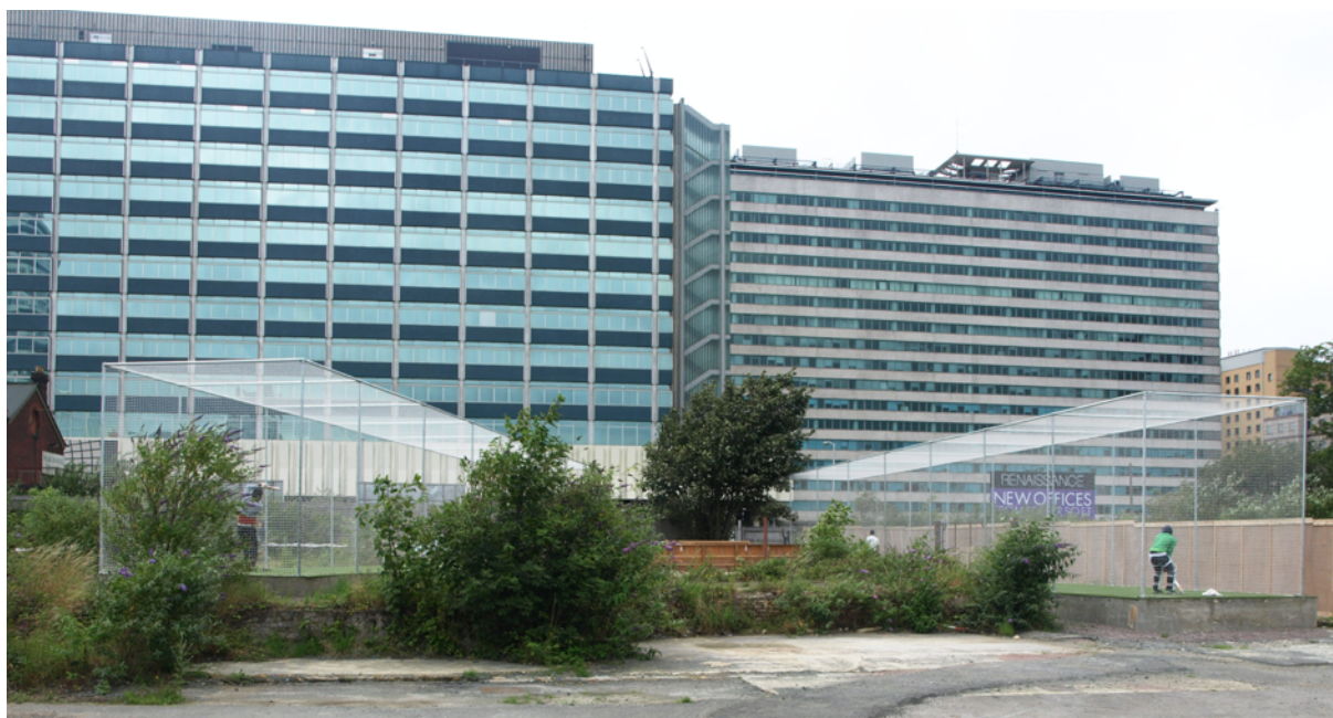
Figura 69. Vista dos dois espaços construídos para a prática de cricket. Foto: arquivo muf architecture/art
