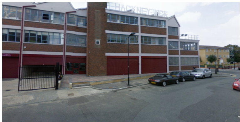
Figura 131. Vista da plataforma existente junto ao edifício Oslo House, antes da intervenção, set. 2008. Foto: © 2022 Google
