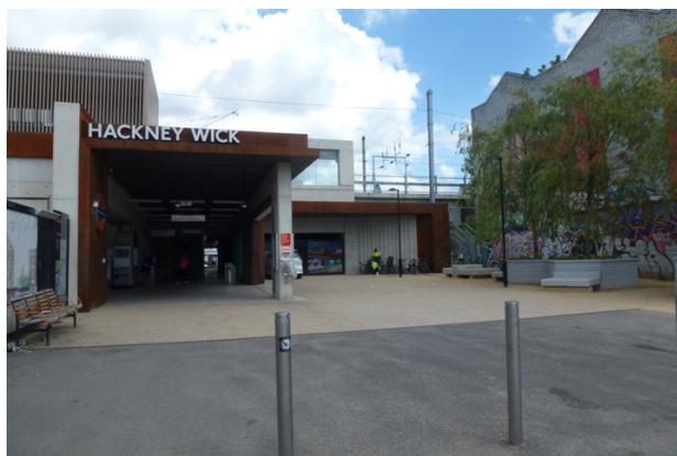
Figura 150. Nova Estação de metro de superfície de Hackney Wick, com saída para White Post Lane. Foto: Cláudia Antunes, agosto 2019
