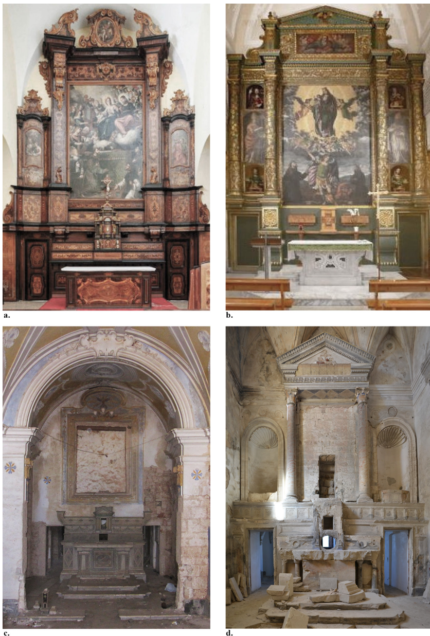
Fig. 10 – Pareti divisorie in legno fra chiesa e coro delle chiese dei cappuccini di Alessano (a) e Rutigliano (b) e in muratura delle chiese dei cappuccini di Conversano (c) e Massafra (d) (chiesa di Alessano: https://www.portalecce.it/index.php/chiesa-in-uscita-diocesi-di-lecce/lo-scaffale/3629-riapre-luogo-caro-a-don-tonino-la-chiesa-dei-cappuccini-di-alessano-restituita-al-culto [Consultato il 29 dicembre 2020]; chiesa di Rutigliano: https://www.crocifissorutigliano.it/culto/la-chiesa-del-santuario/ [Consultato il 29 dicembre 2020]; chiesa di Conversano: foto di V.A. Barnabà, M.A. Catella, N. Catella, 2011; chiesa di Massafra: foto di G. Bevilacqua, A. Borrelli, D. Carbonara, F. Carrieri, S. Leone, 2015).
